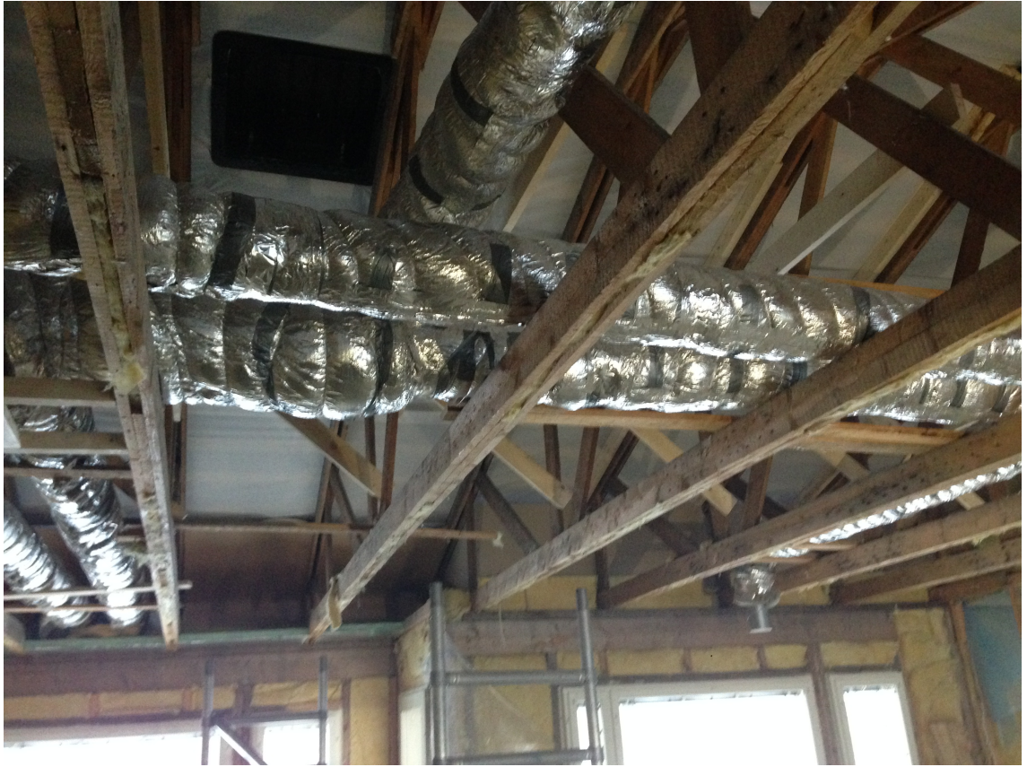
Kuva 6. Putkieristystä
