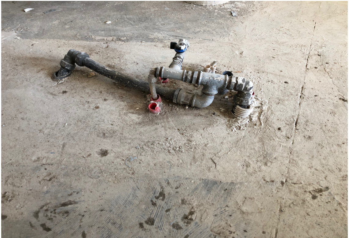
Kuva 3. Vanha varaajan paikka
