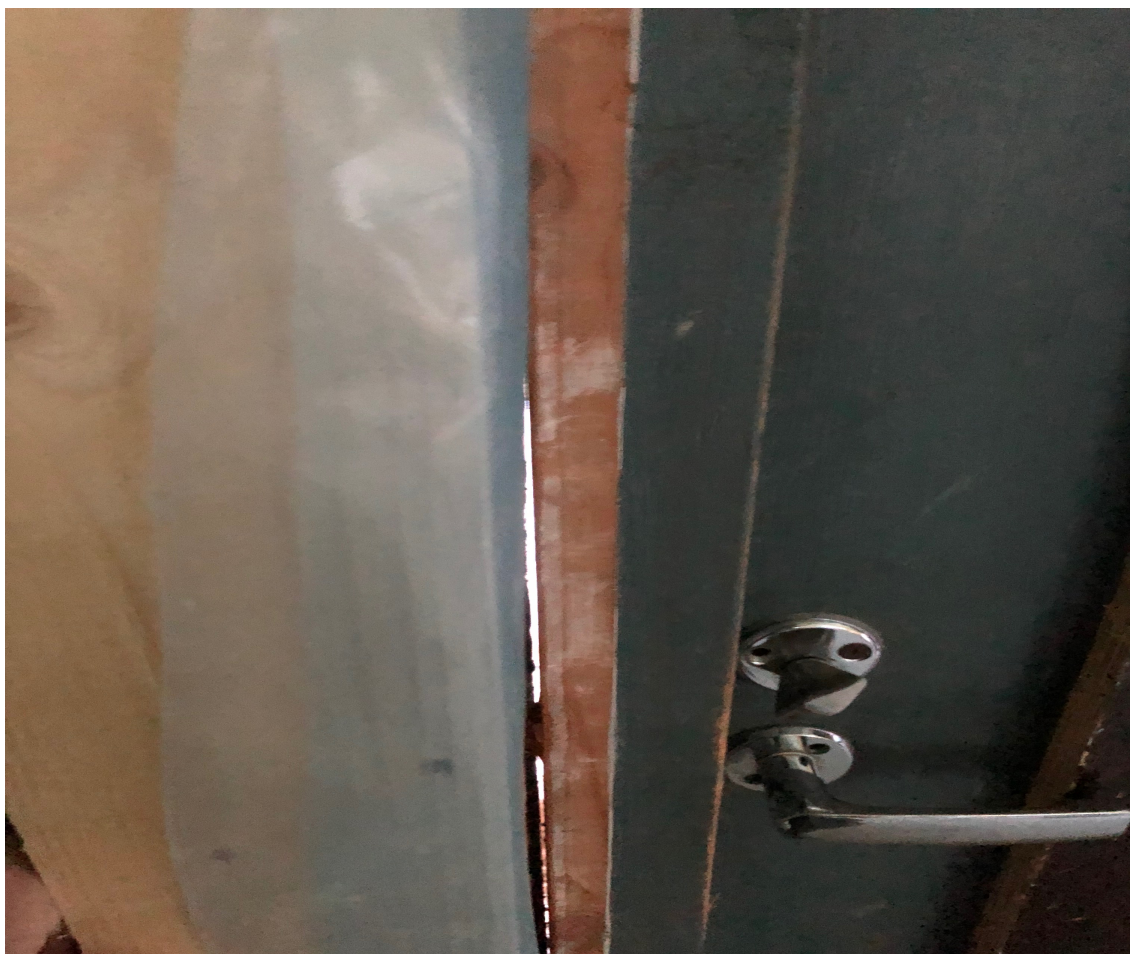
Kuva 5. Puutteellinen eristys
