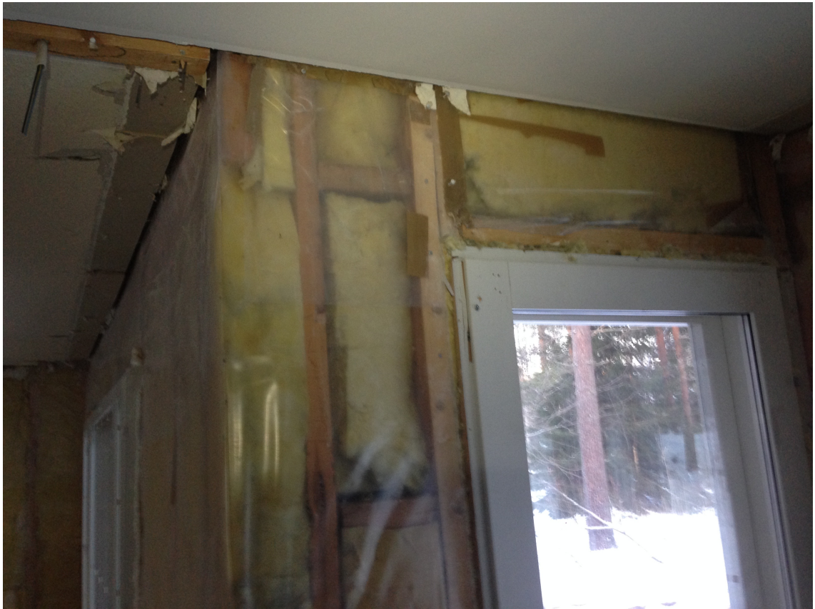
Kuva 2. Virheellinen eristys
