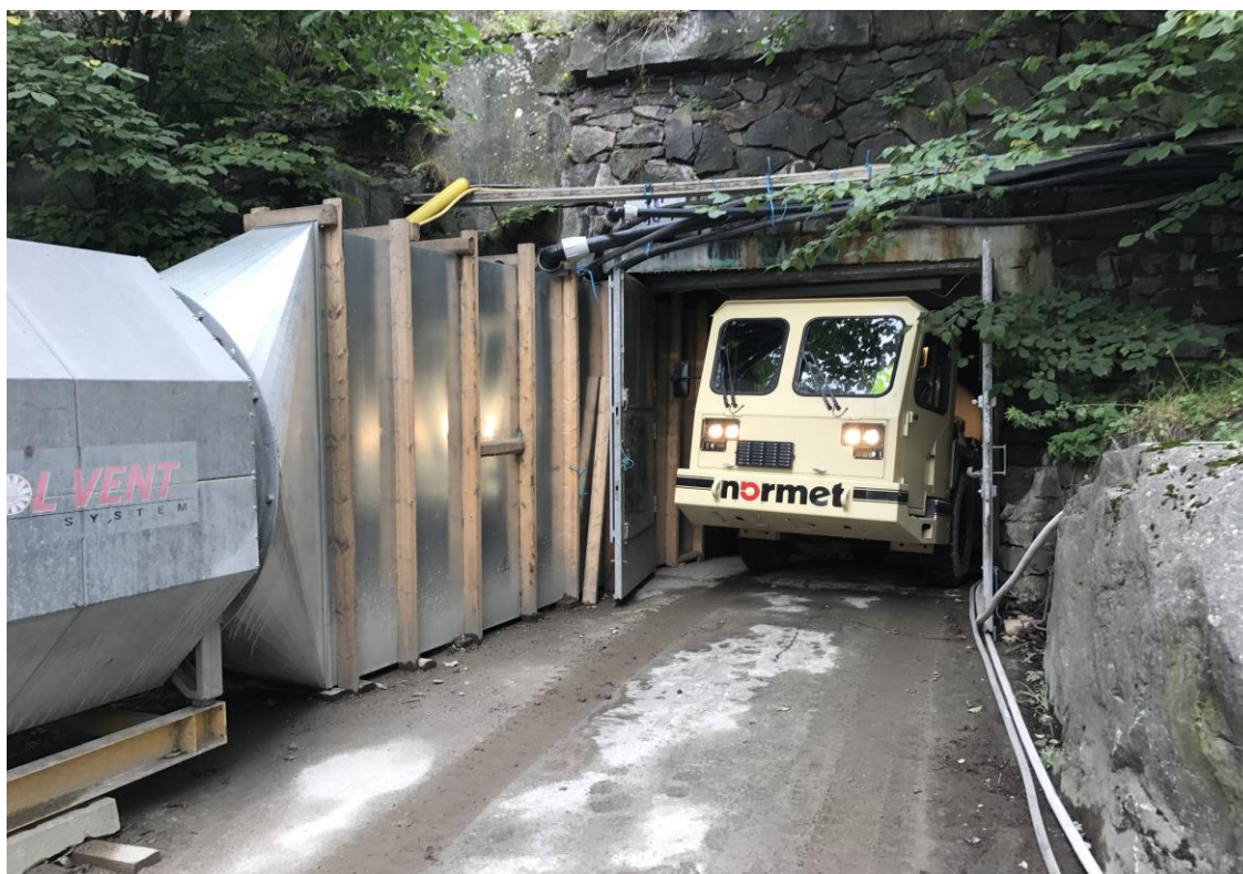
Kuva 14. Työmaalla betonin kuljetukseen käytetty säiliö. [Rinkinen, 2017, YIT]
