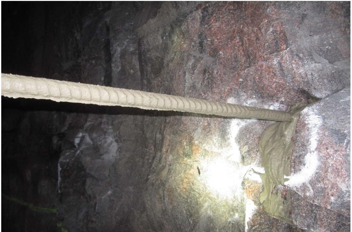
Kuva 6. Harjateräspultin juotto sementillä. Laadunvalvontana tehty vetokoe. [Turkia, YIT, 2017]
