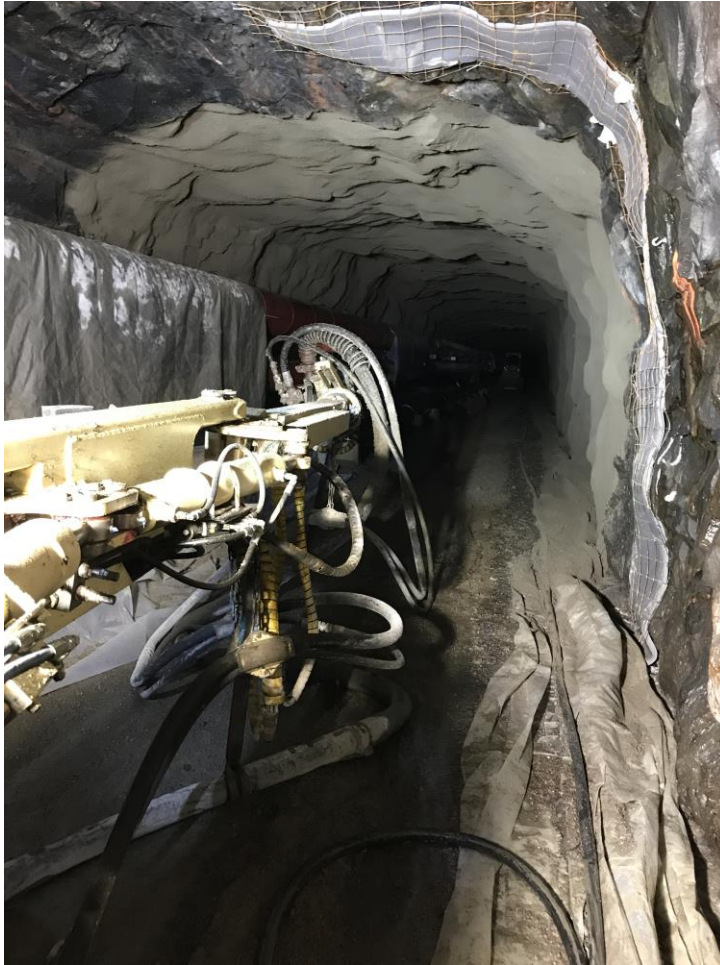
Kuva 21. Suojaukset ruiskubetonointia varten. [Rinkinen, 2017, YIT]
