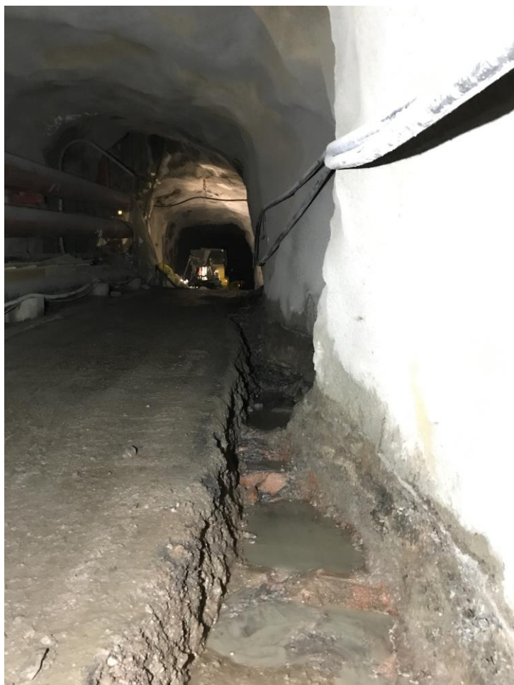
Kuva 13. Avo-oja selvästi esillä. Pohjatöiden yhteydessä ojaan asennettiin salaojaputki ja täytettiin salaojasepelillä. Näin massiiviset vuotovedet saatiin piiloon, mikä vaikuttaa radonarvoihin laskevasti. [Rinkinen, 2017, YIT]
