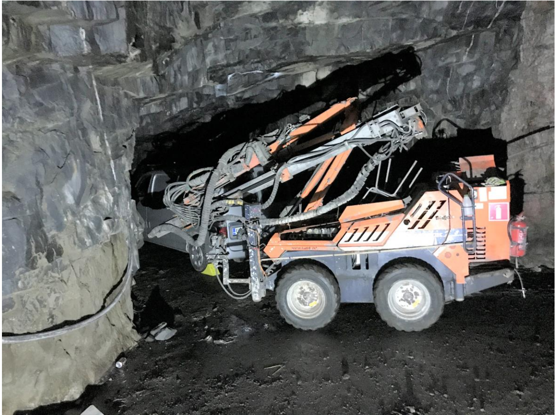
Kuva 1. Commando tunnelissa. [Rinkinen, 2017, YIT]
