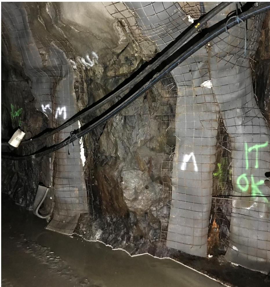
Kuva 20. Esimerkki ruiskubetonisalojasta, jonka tarkoituksena on ohjata vuotovesi tunnelin tien tasolle asennettavaan salaojaan. [Rinkinen 2017, YIT]
