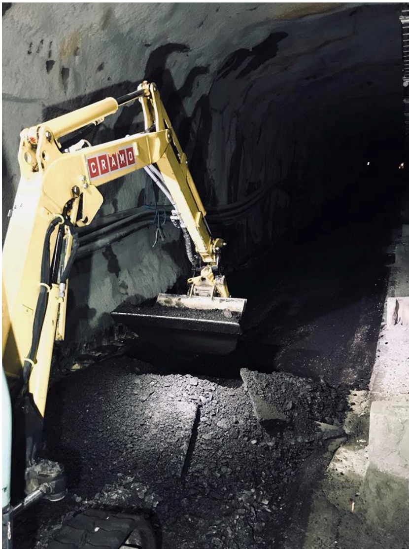
Kuva 23. Rouheen lastaus. [Rinkinen, 2017, YIT]
