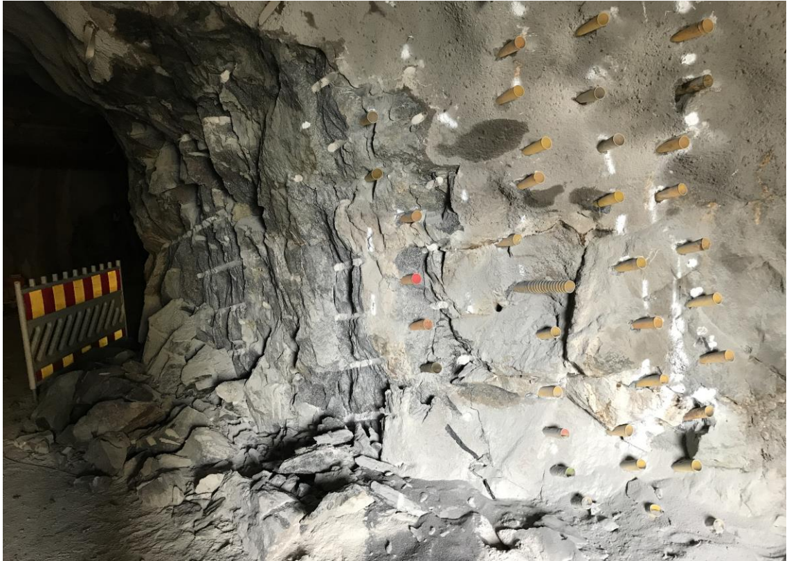
Kuva 4. Etanointia. [Rinkinen 2017, YIT]
