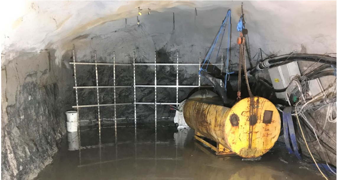
Kuva 18. Työnaikainen pumppaus. [Rinkinen 2017, YIT]
