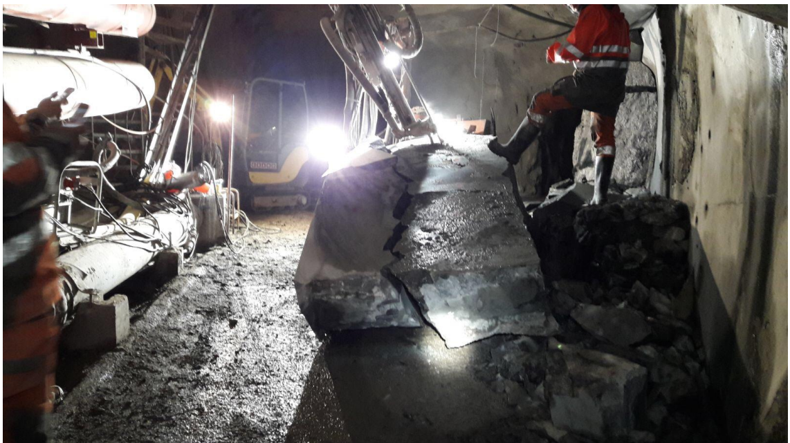
Kuva 3. Vaijerisahauksen jälki nähtävissä oikealla. Kalliosta saatiin irrotettua siististi tarvittava kiviaines. [Rinkinen 2017, YIT]
