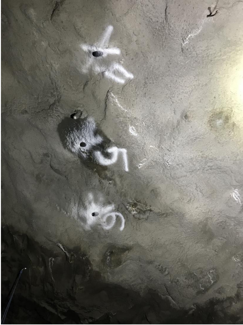
Kuva 10. Jälki-injektointia varten poratut injektointireiät. [Rinkinen, 2017, YIT]
