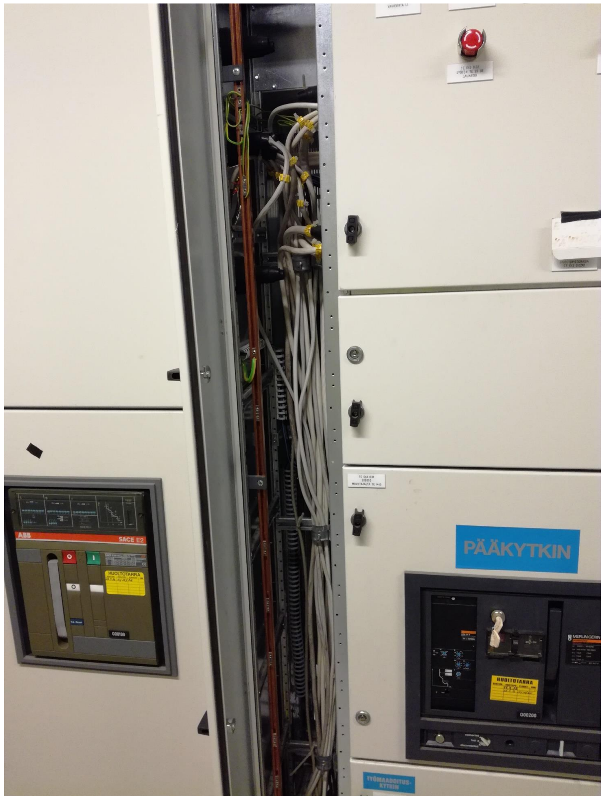
Kuvio 16. Keskuksen sisäisiä kaapelointeja. PE-merkinnät voisi olla muullakin tavalla kuin tussilla tehtyjä.
