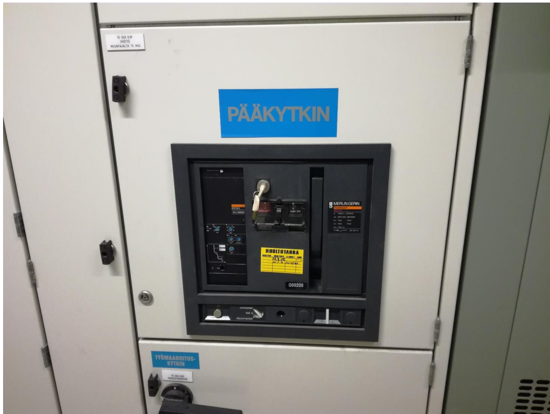
Kuvio 5. Pääkytkimen katkaisija, Huolto ajan tasalla
