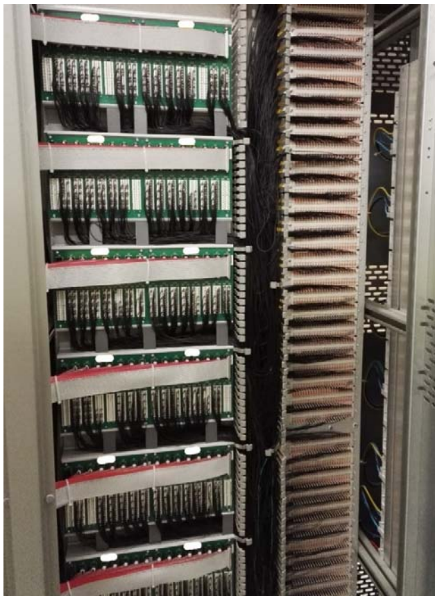
Kuva 6 HPN3 Ristikytkentäkaappi
