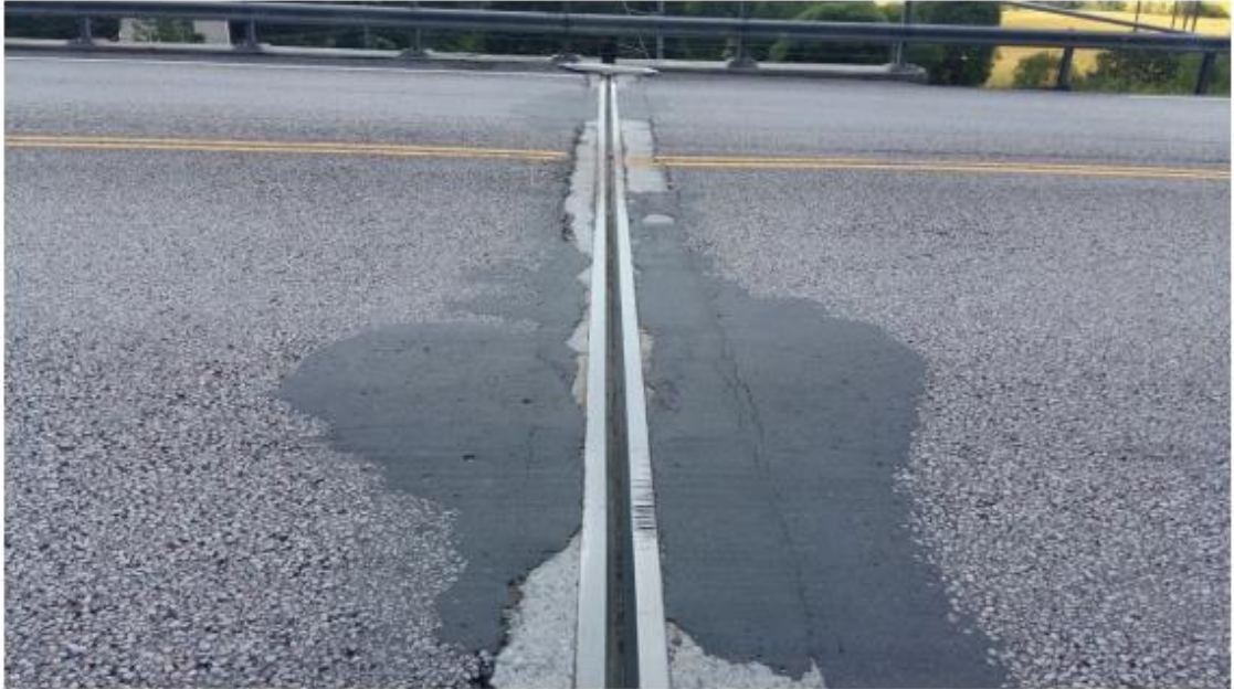
Kuva 2. Liikuntasaumalaite tukikaistoineen ja valuasfalttipaikkauksineen. (Sami Katajamäki)
