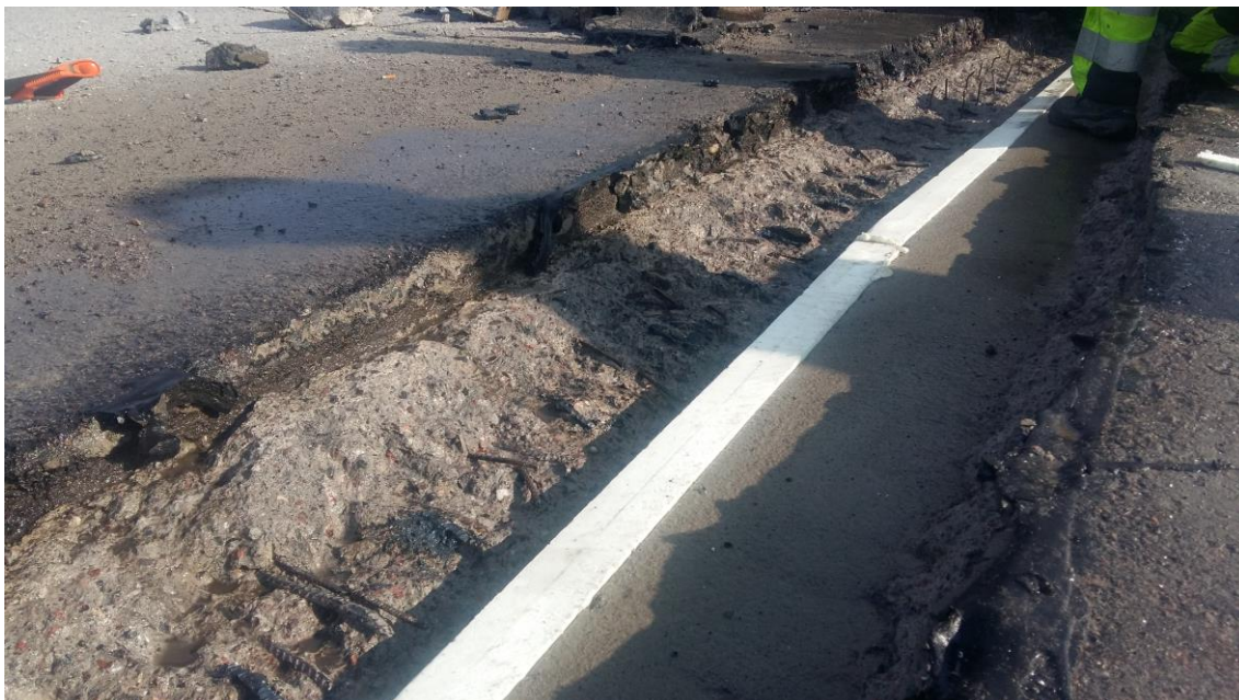
Kuva 13. Purettu liikuntasaumalaite ja kannenpuoleisen osan tasausvalu. (Otto Suominen)
