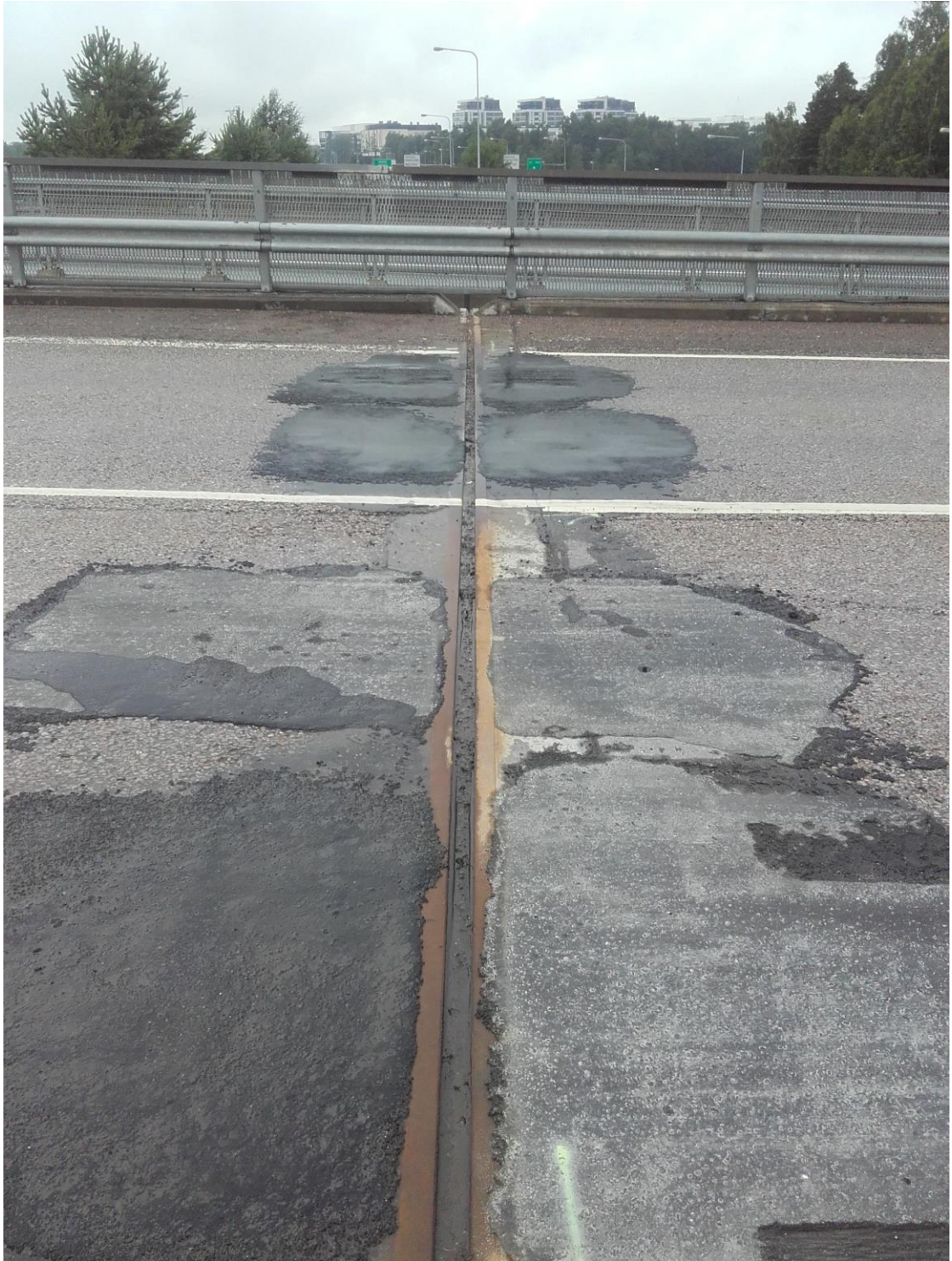
Kuva 7. Kumiprofiilin väliin kerääntyneitä epäpuhtauksia. (Sami Katajamäki)
