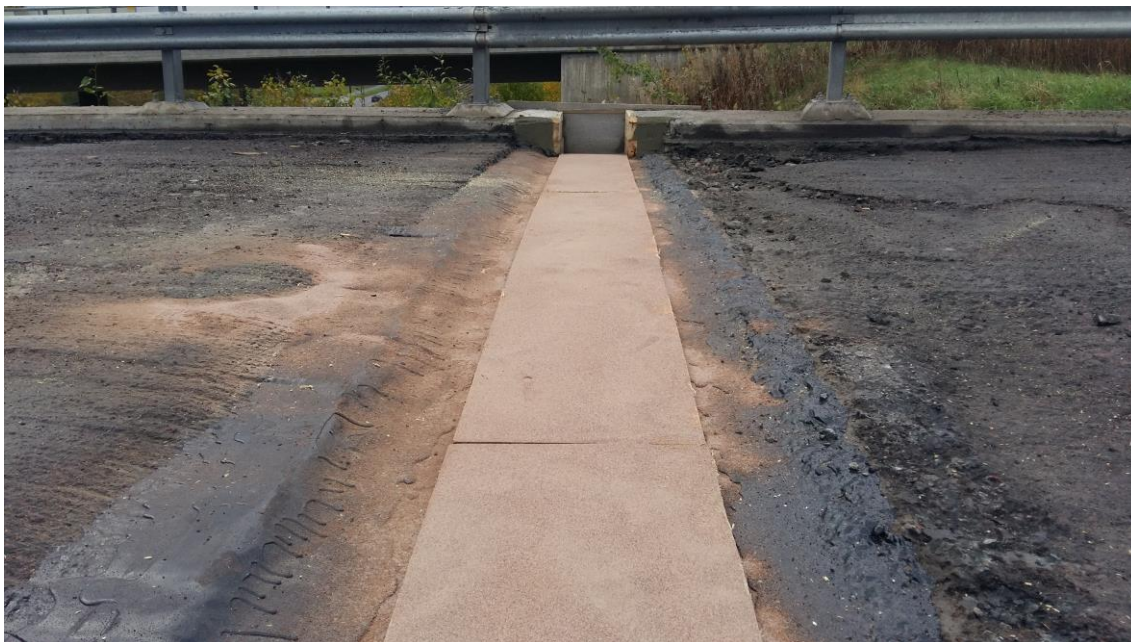
Kuva 15. Irrotuskaista ja muokatut reunapalkit. (Otto Suominen)
