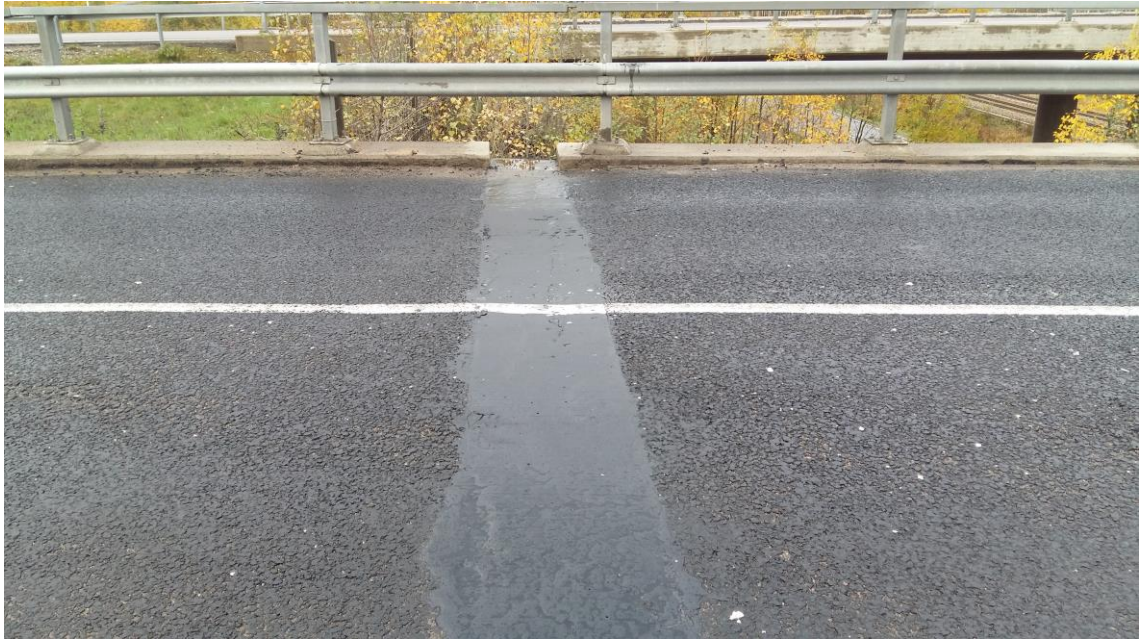
Kuva 17. Valmis massaliikuntasauva. (Otto Suominen)
