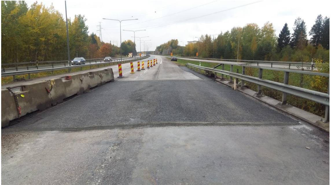
Kuva 16. Liikuntasaumavälin päällystys. (Otto Suominen)
