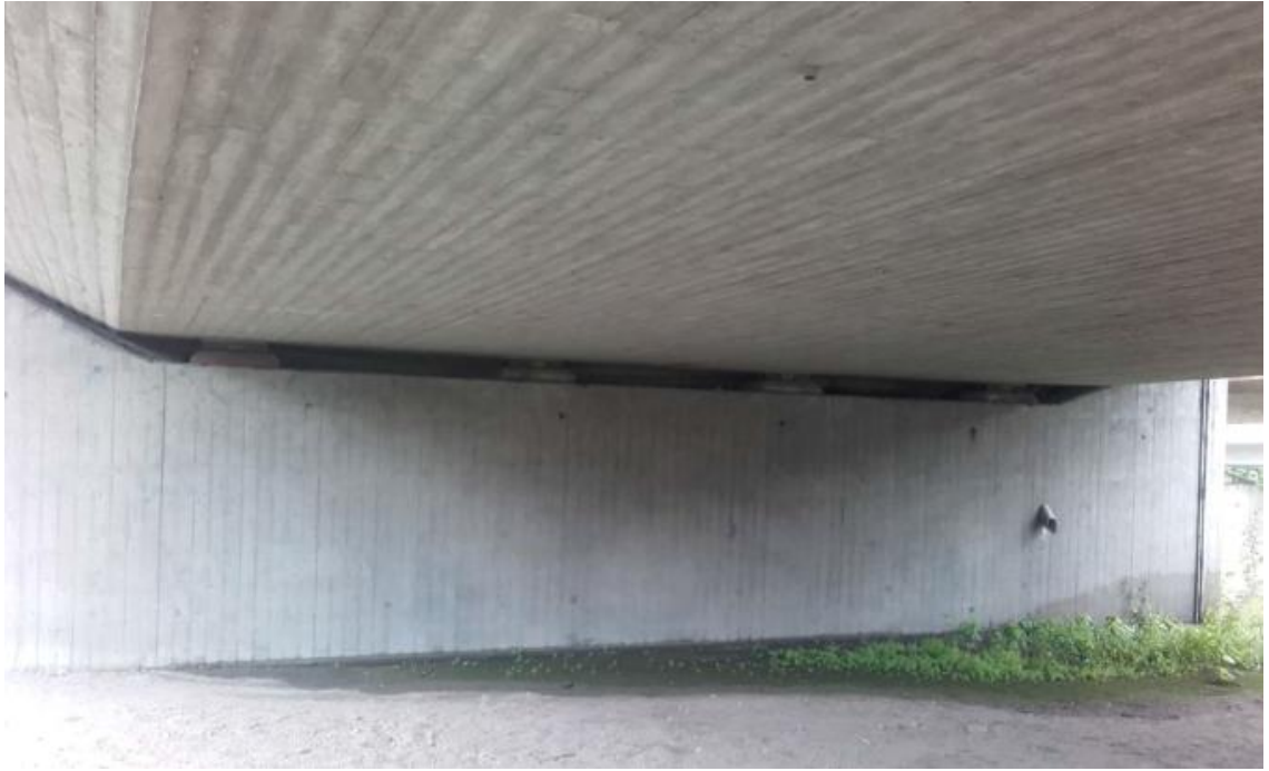
Kuva 6. Liikuntasauman vesitiiviys voidaan tarkastaa sillan alta vuotojälkien perusteella. (Sami Katajamäki)
