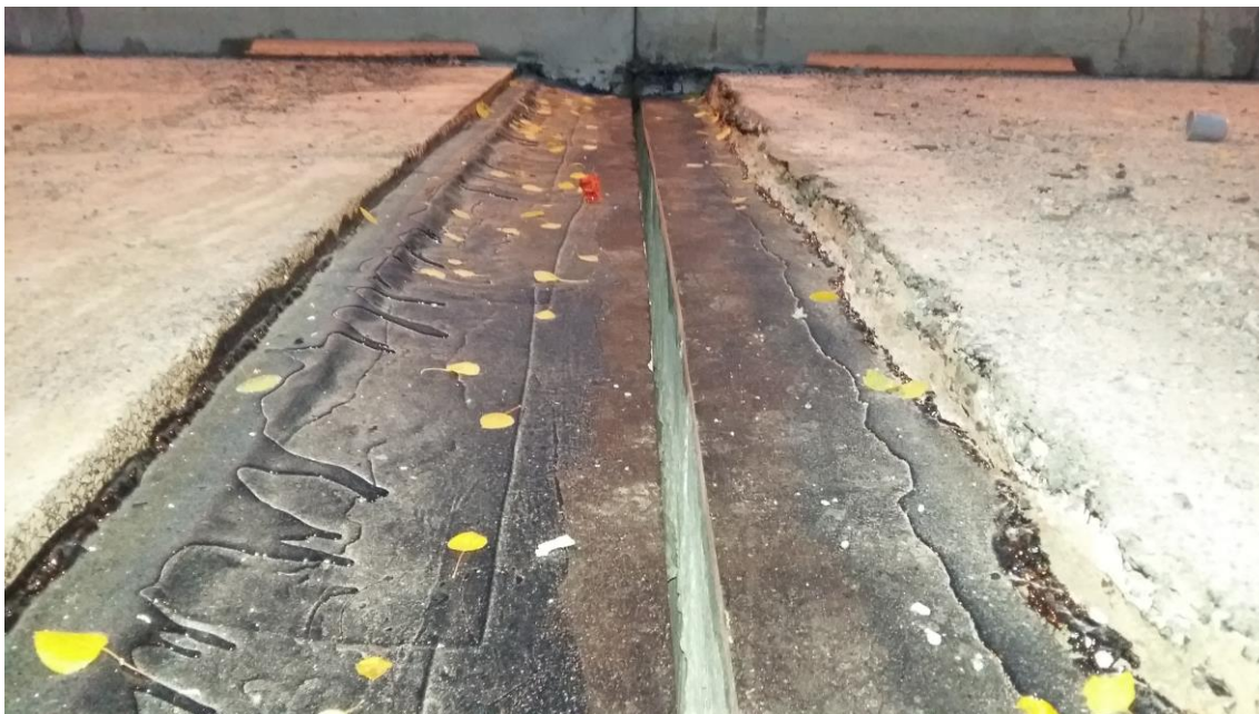
Kuva 14. Vesieristys. (Otto Suominen)
