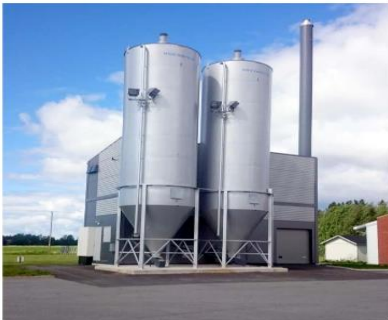
Kuva 6. Ulvilan lämpökeskus (Pärssinen 2016)
