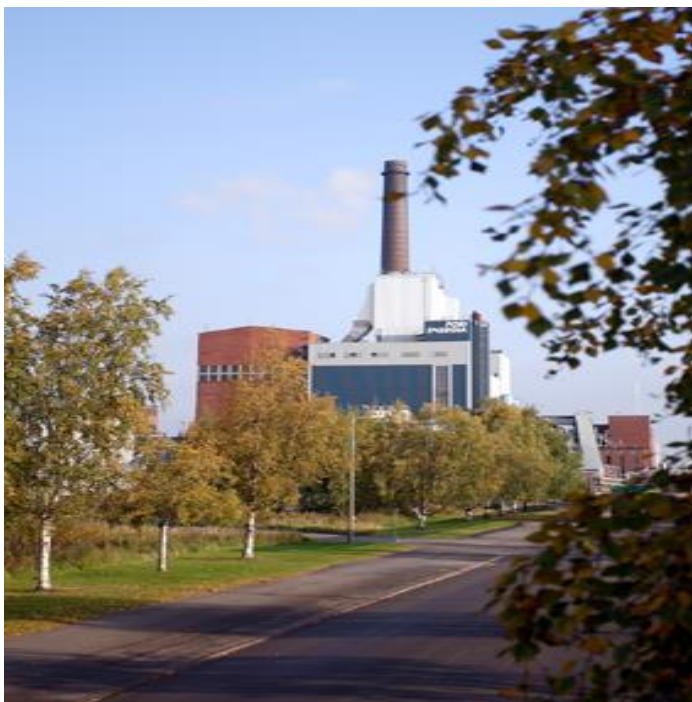
Kuva 1. Aittaluodon voimalaitos (Pori Energia Oy:n www-sivut 2018)
