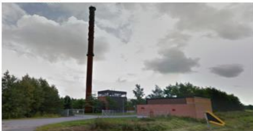
Kuva 4. Ulasoorin lämpökeskus (Kari Nyqvist 2016)
