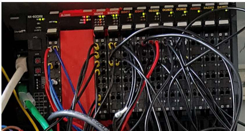
Kuva 2. Kuvassa kappaleenkäsittelylaitteiston I/O keskus.
