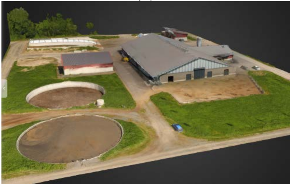
Kuva 30. Kuvakaappaus 3D-mallista joka on tehty Mustialan navetasta ja sen ympäristöstä Dronedeploy-ohjelmalla (Rekola, 2017)
