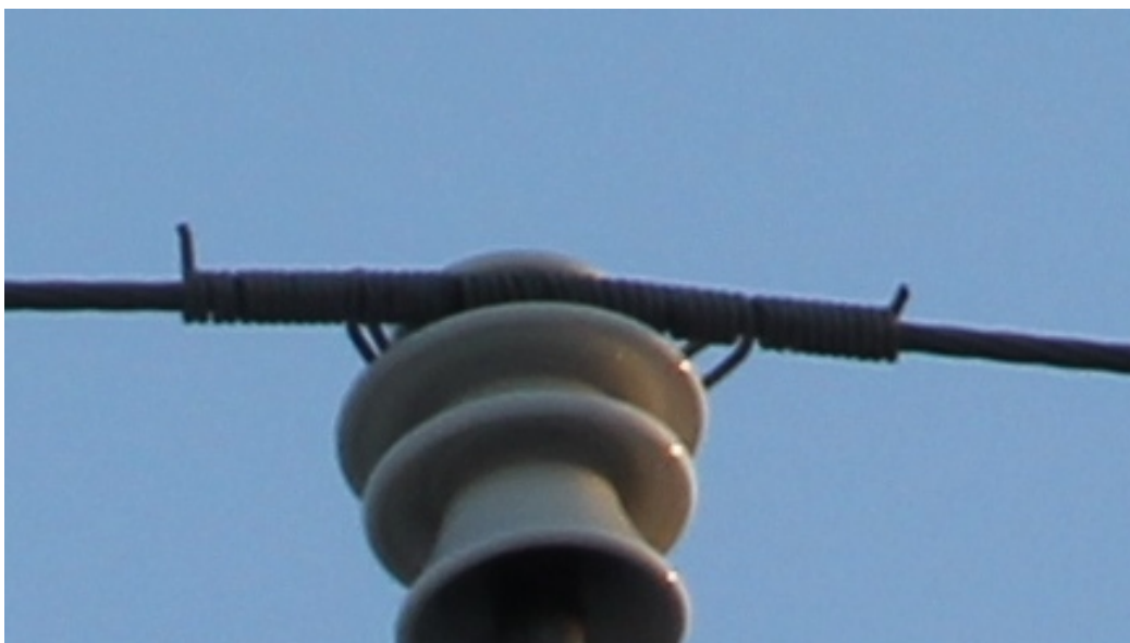
KUVA 4-9. Elenian verkossa tehty avojohtimen sidonta eristimen viereen (Timo Juntunen 2018)
