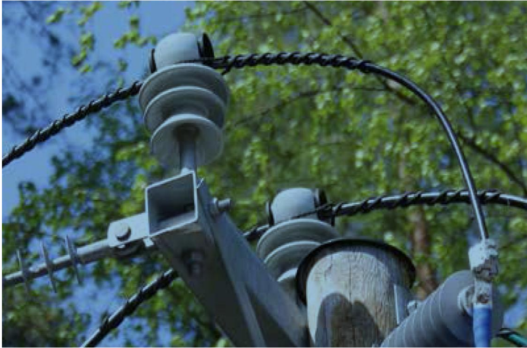
KUVA 4-13. Esijännitetyt siteet vastakkaisiin suuntiin (ENSTO 2018)
