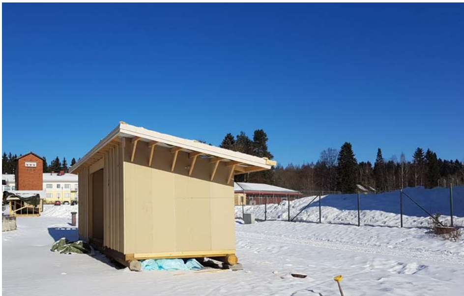
KUVA 3-3. Asennustilat tekeillä sisäasennusharjoituksiin (03/2018 Timo Juntunen)
