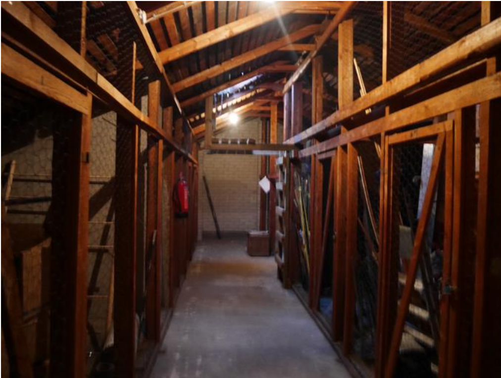
Kuva 5. Ullakon häkkivarastotilaa ja varastokäytävä
