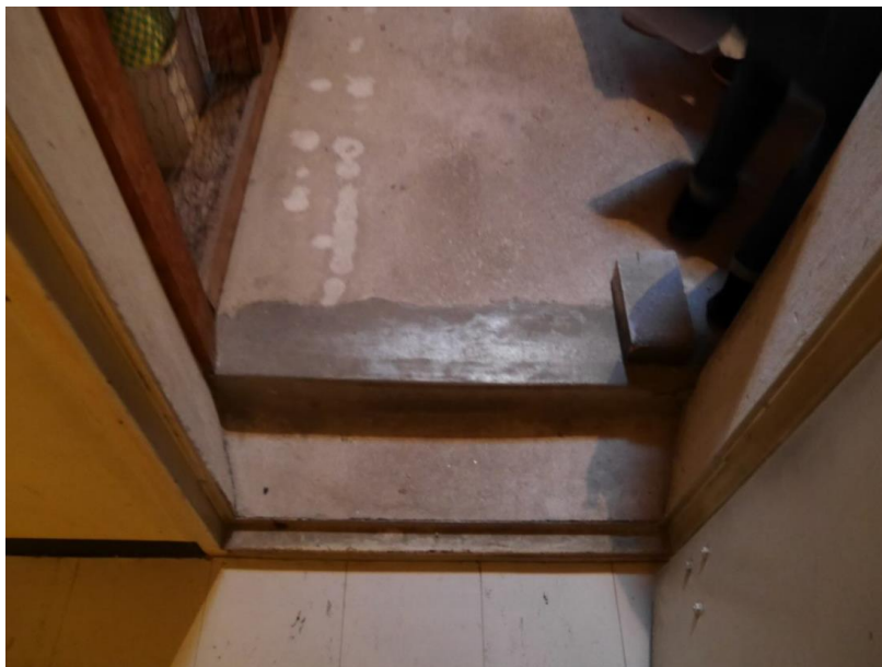
Kuva 6. Ullakkotilojen lattiakorot vaikuttavat esteettömyyteen
