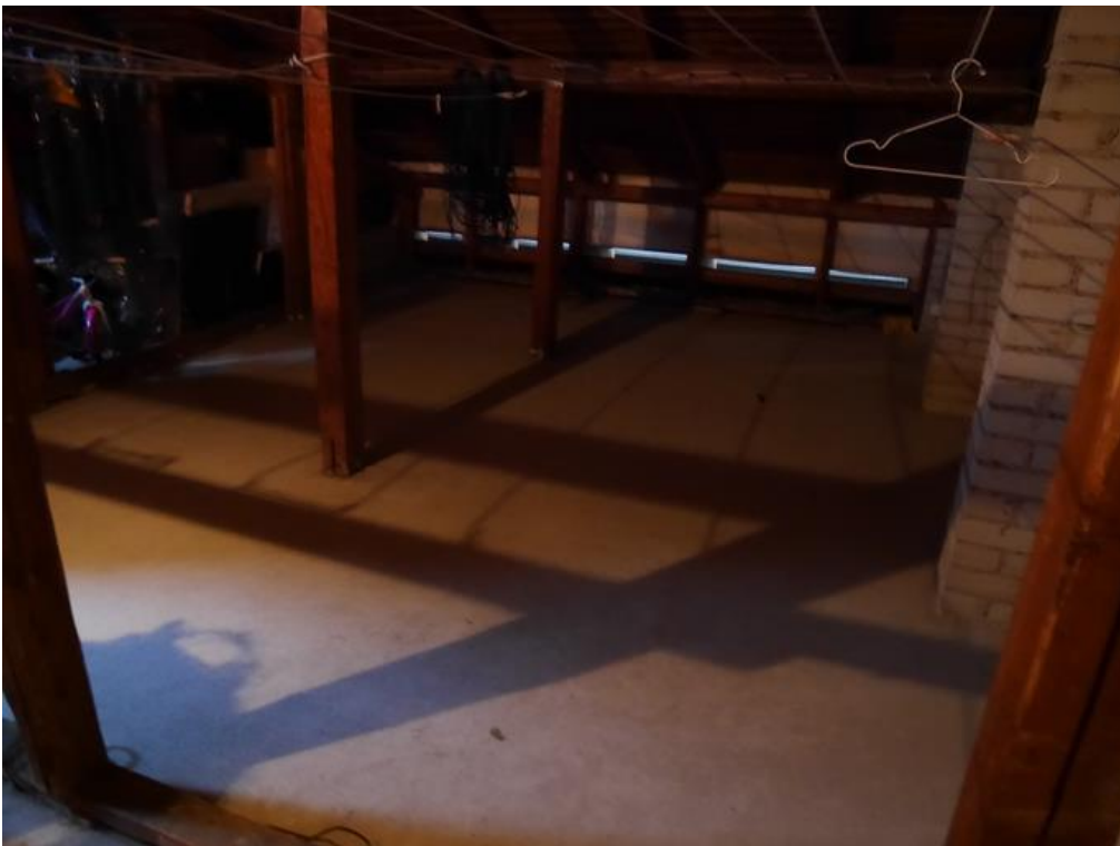
Kuva 6. Ullakon pyykinkuivaustilaa ja kantavia kattopilareita.
