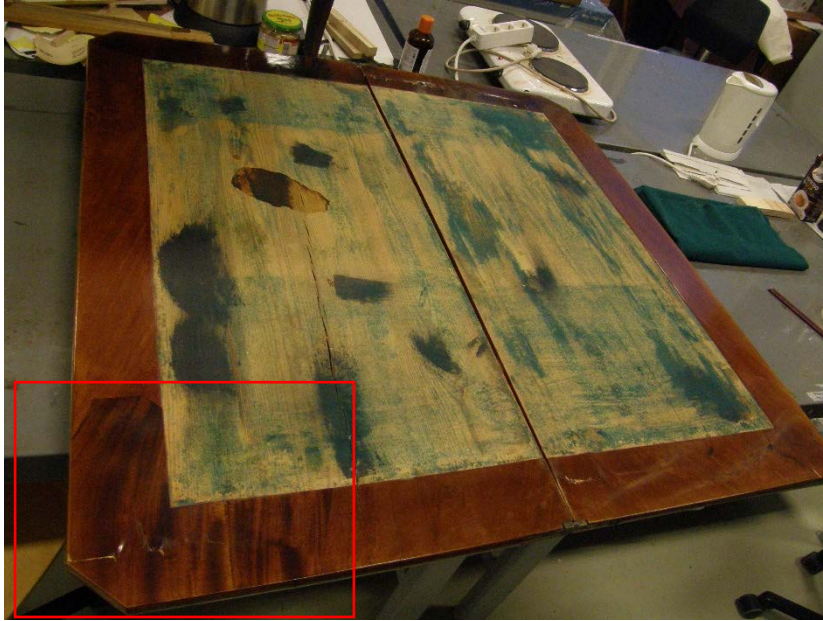
Kuva 28. Kansi veran irrotuksen jälkeen (Roivas 2018)
