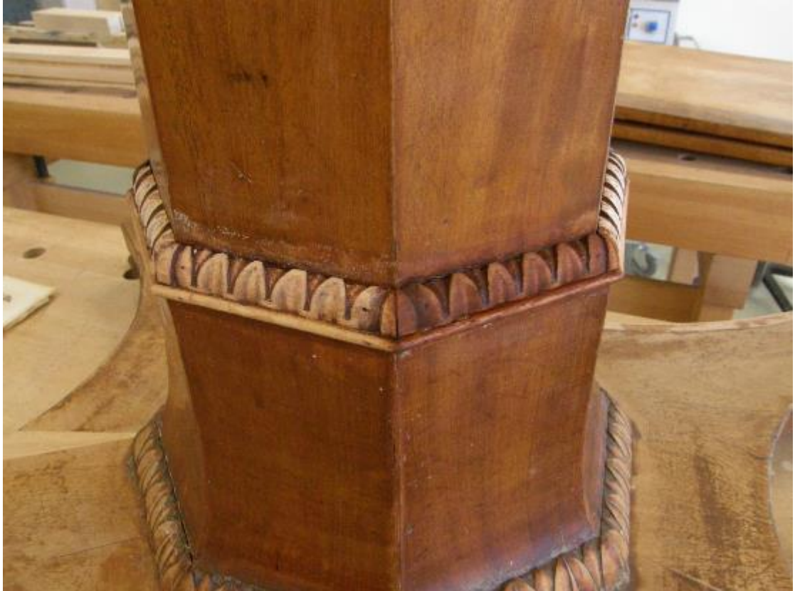
Ylemmät koristelistat lakan poiston jälkeen (Roivas 2018)
