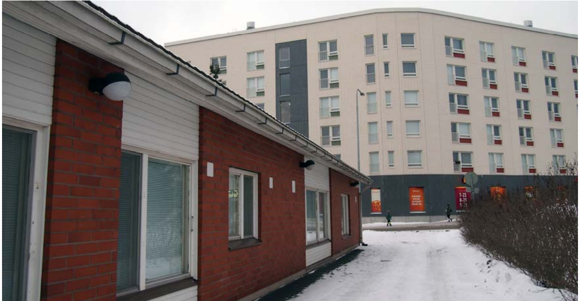
Kuva 6. Näkymä päiväkotirakennuksen pohjoispuolelta Kissanmaankadulle.
