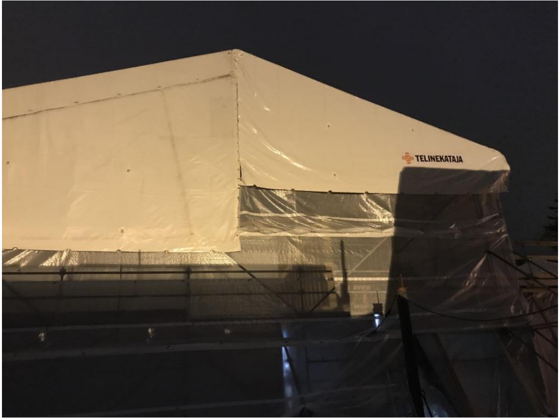
Kuva 6. Hukanhaudan päiväkodin sääsuojausteltoa.
