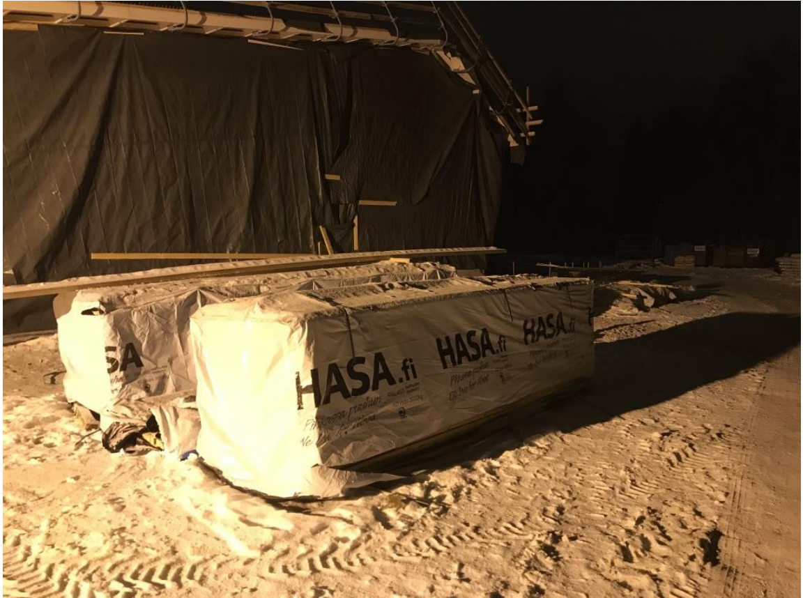
Kuva 2. Hukanhaudan päiväkodilla materiaalien varastointia ulkotiloissa.
