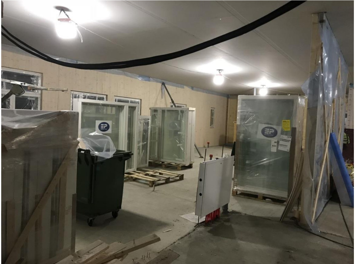
Kuva 3. Hukanhaudan päiväkodilla materiaalien varastointia sisätiloissa.
