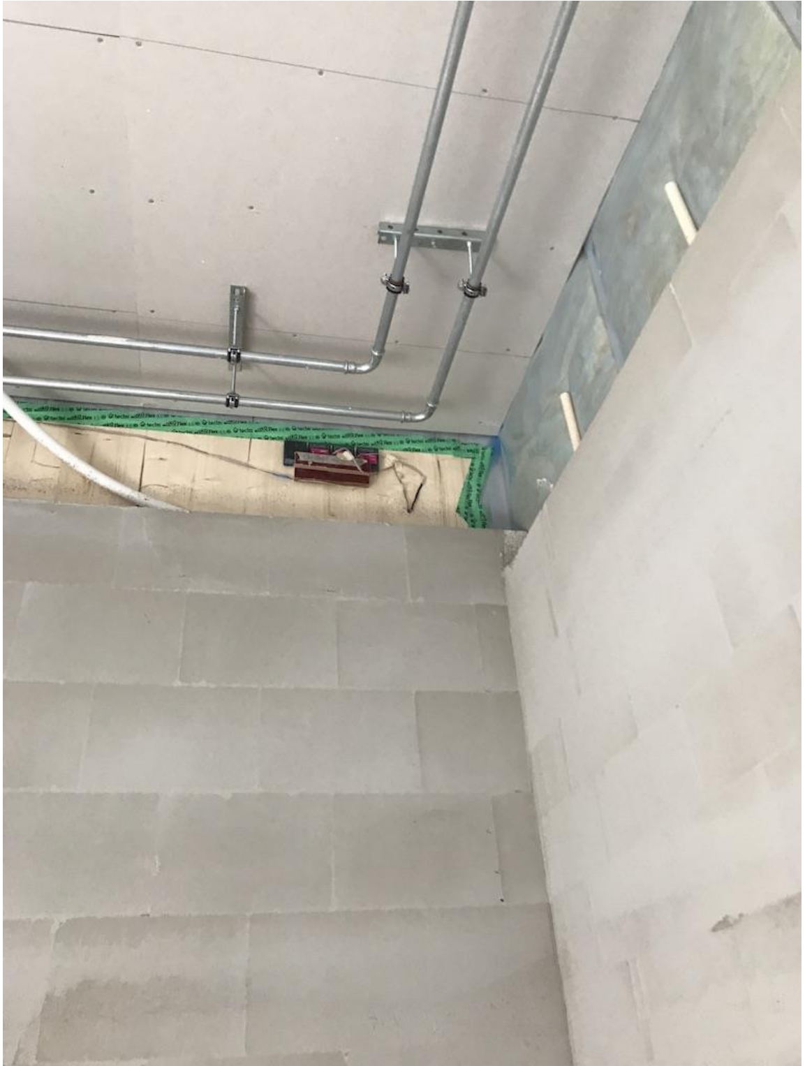
Kuva 10. hukanhaudan päiväkodin kolmannessa lohossa olevat SiMAP anturit.
