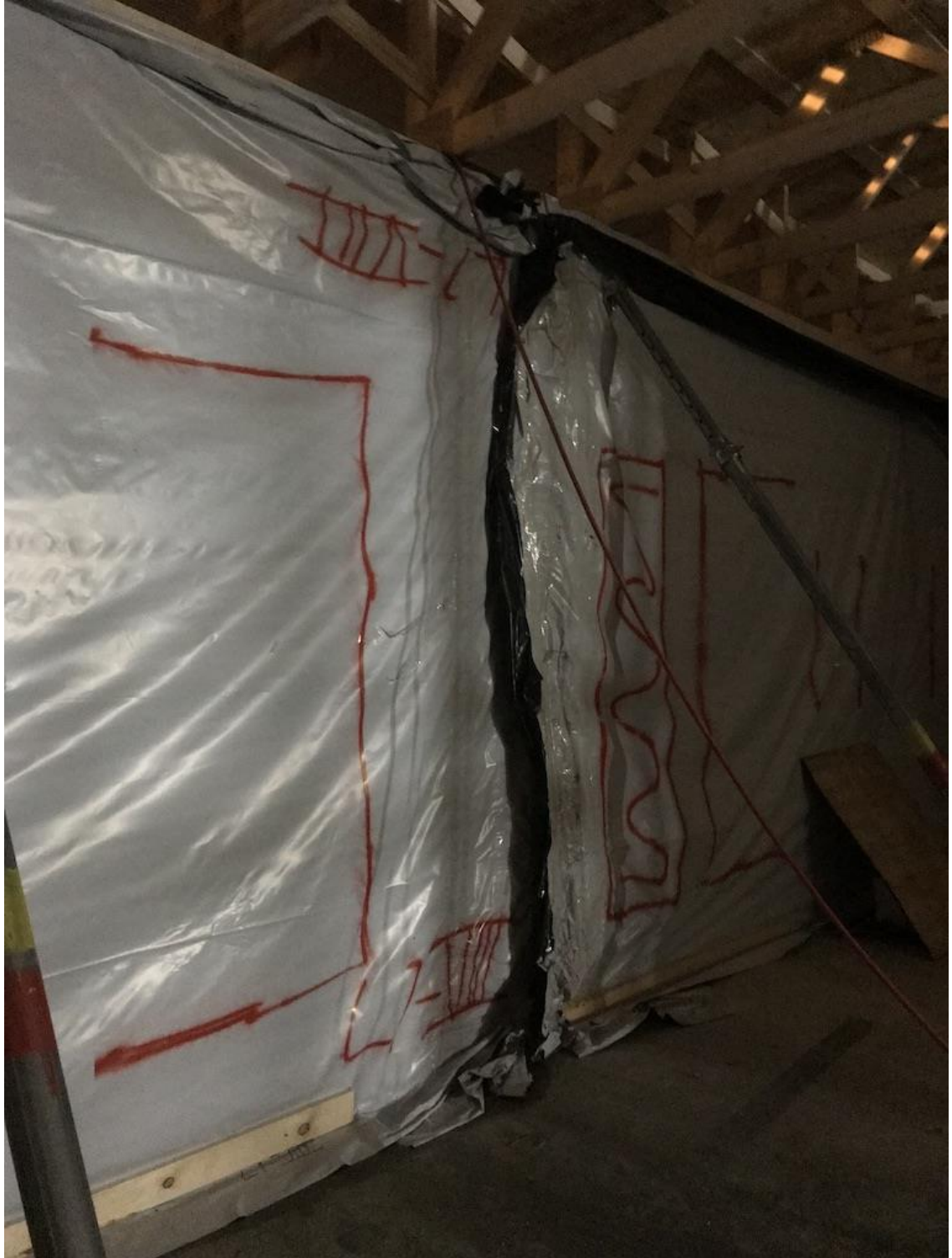
Kuva 4. CLT elementtien tehtaalla valmiiksi asennetut suojaushuput.
