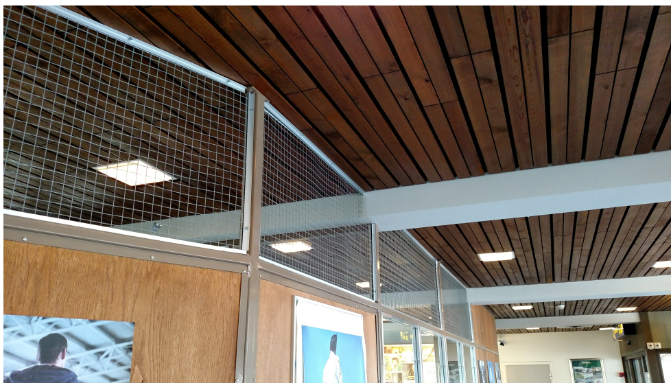
Kuva 20. Metalliristikot välikäytävän ja boarding-alueen välisessä seinässä (Eloranta 2018)
