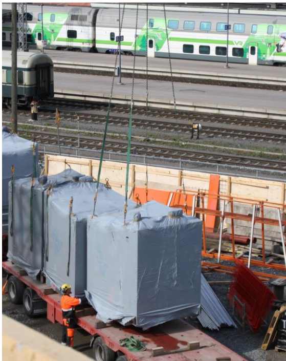
KUVAT 8 ja 9. Parmarine Oy:n valmistaman kylpyhuone-elementin siirtoa työmaalla ja valmis kylpyhuone Lappeenrannan opiskelija-asuntosäätiö LOASin Timpassa. (Tarvike-tietokortti, RT 38436. Parma Kylpyhuoneet, Parmarine Oy, 2013. http://www.parmarine.fi/fi/references/ .)
