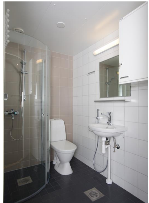
KUVAT 8 ja 9. Parmarine Oy:n valmistaman kylpyhuone-elementin siirtoa työmaalla ja valmis kylpyhuone Lappeenrannan opiskelija-asuntosäätiö LOASin Timpassa. (Tarvike-tietokortti, RT 38436. Parma Kylpyhuoneet, Parmarine Oy, 2013. http://www.parmarine.fi/fi/references/ .)
