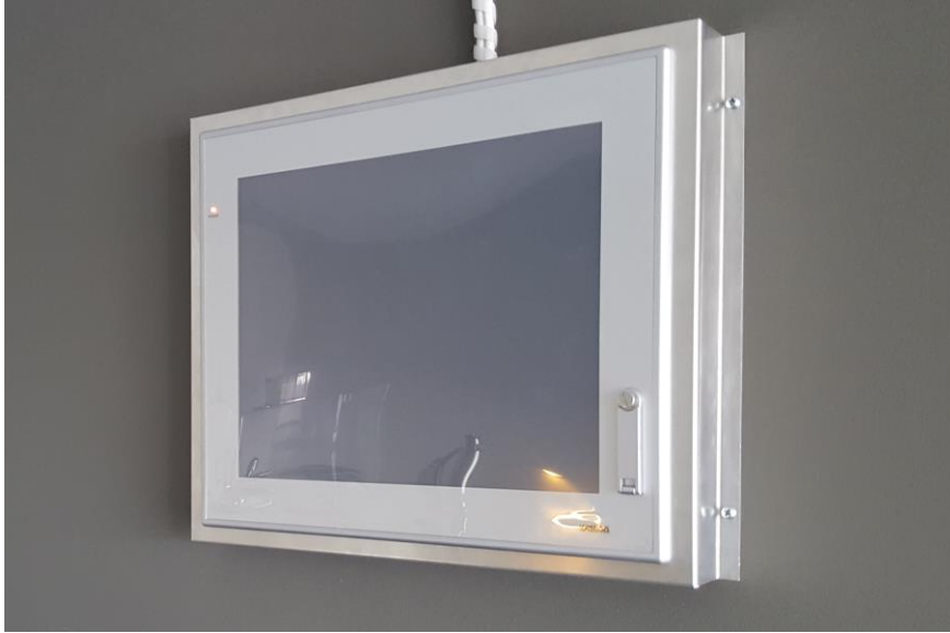
KUVA 2. Alkuperäinen taloautomaatiojärjestelmän käyttöliittymä (Hautaniemi 2018)
