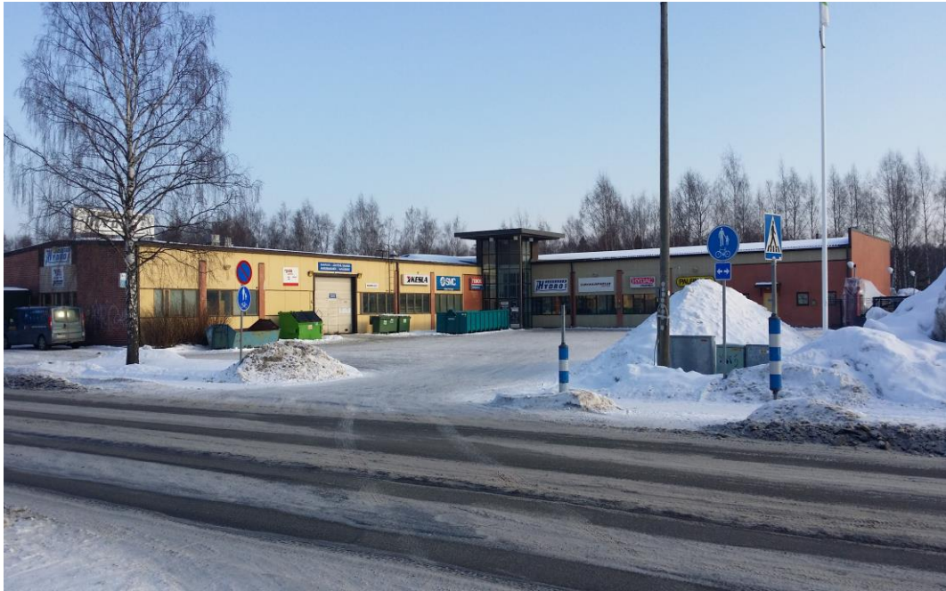
Kuva 6. Julkisivukuva Lakeuden Hydron hallista.
