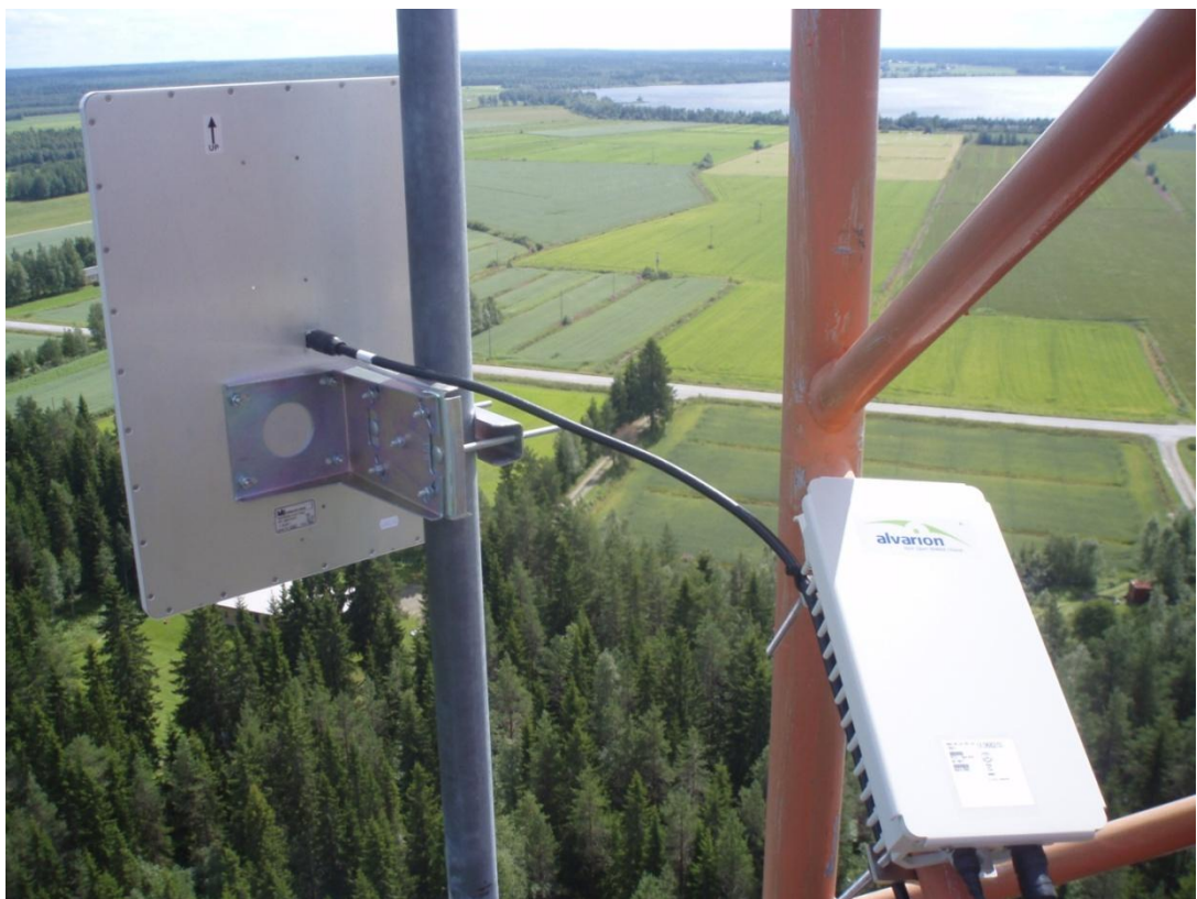
KUVA 1. Antenni, radiolähetin sekä hyppykaapeli Parkkilan mastossa. (Salmela 2009)
