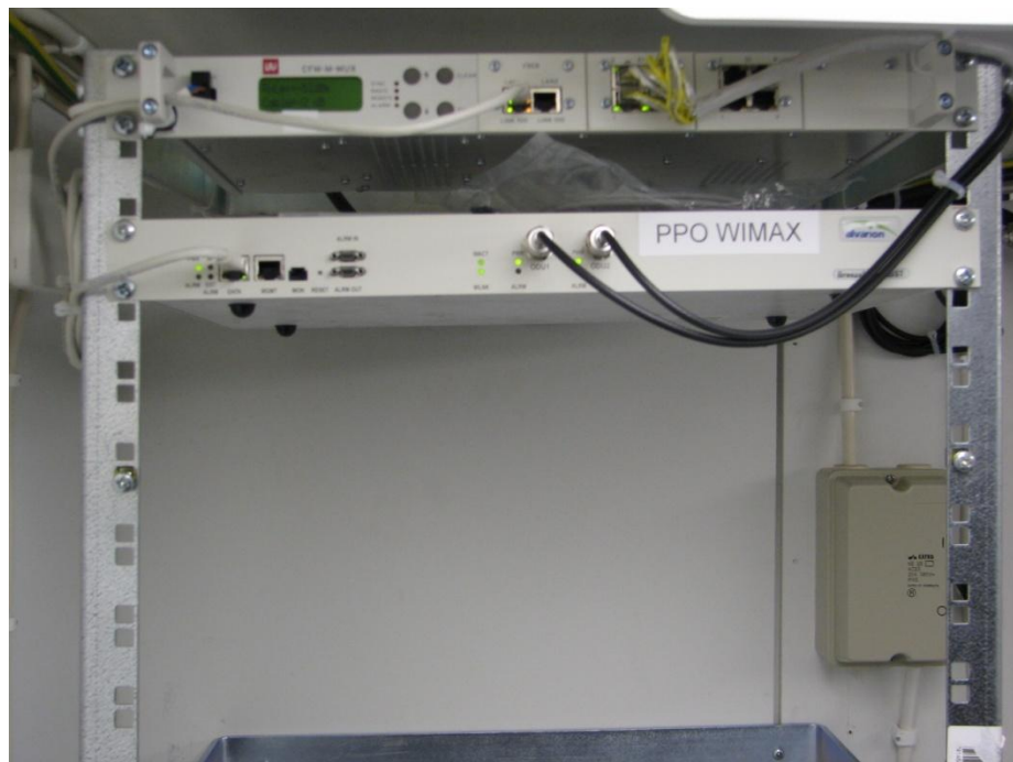
KUVA 2. BreezeMAX – tukiasema asennettuna. Kuvassa näkyy myös SAF CFM sisäyksikkö, jonka kautta WiMAX-tukiasema on reititetty. (Salmela 2009)
