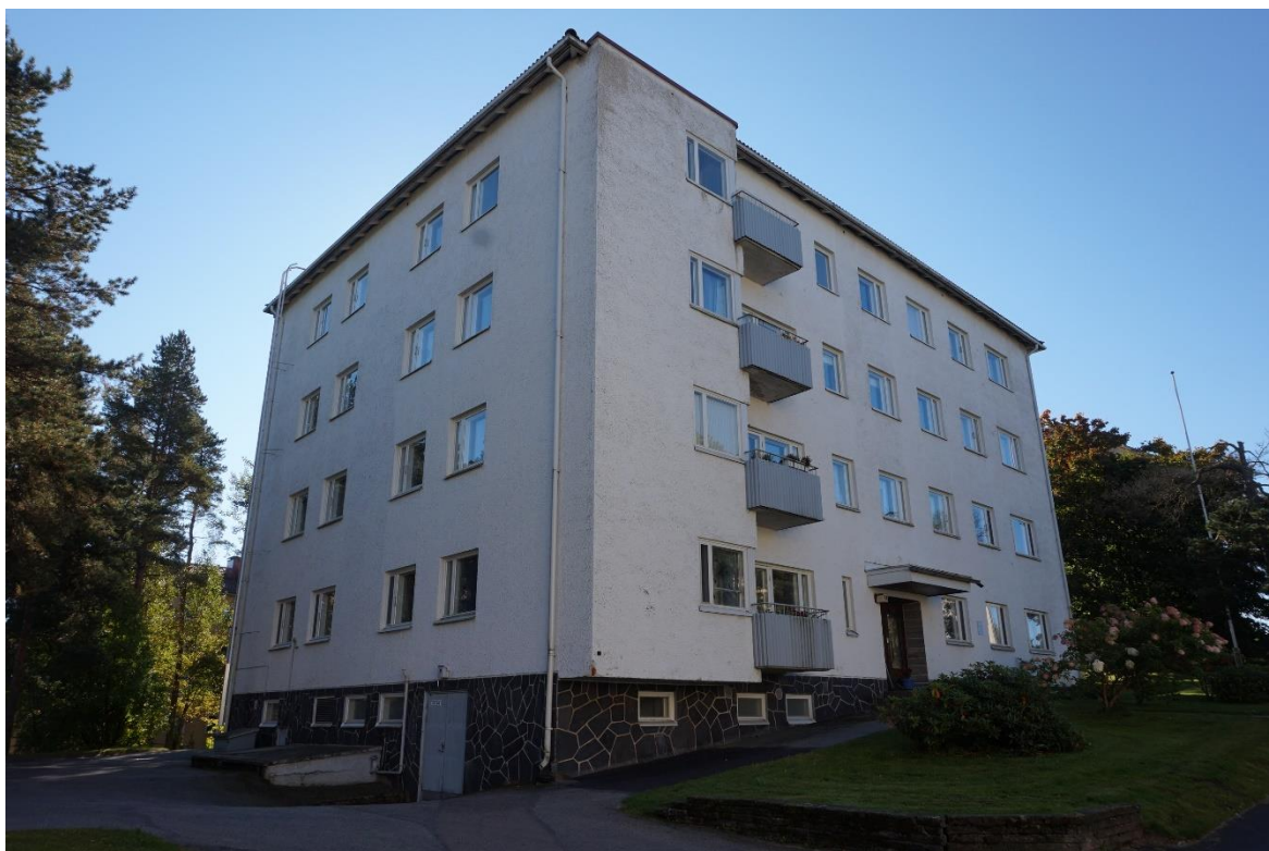
KUVA 7. Jälleenrakentamisen aikakauden asuinkerrostalo, Herttoniemi, Helsinki (Ahvenainen 2016-06-16)
