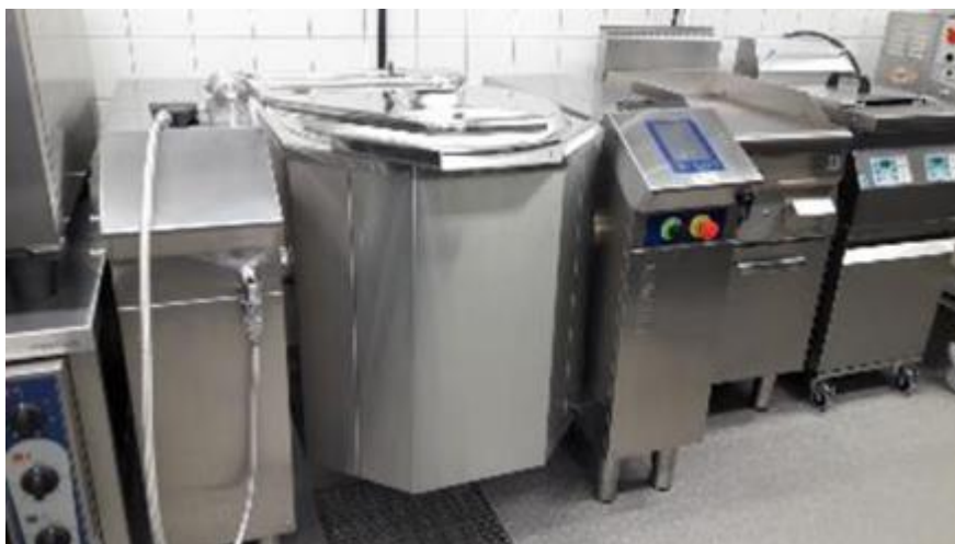
KUVA 7. Dieta Premier -monitoimipata (Laakkonen 2018-02-19.)
