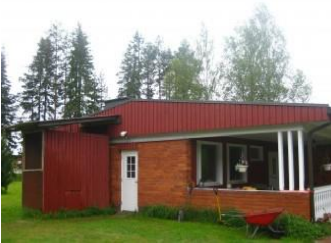
KUVA 16. Omakotitalon päätyyn rakennettu ja ulkoverhoiltu pellettisiilo (23)
