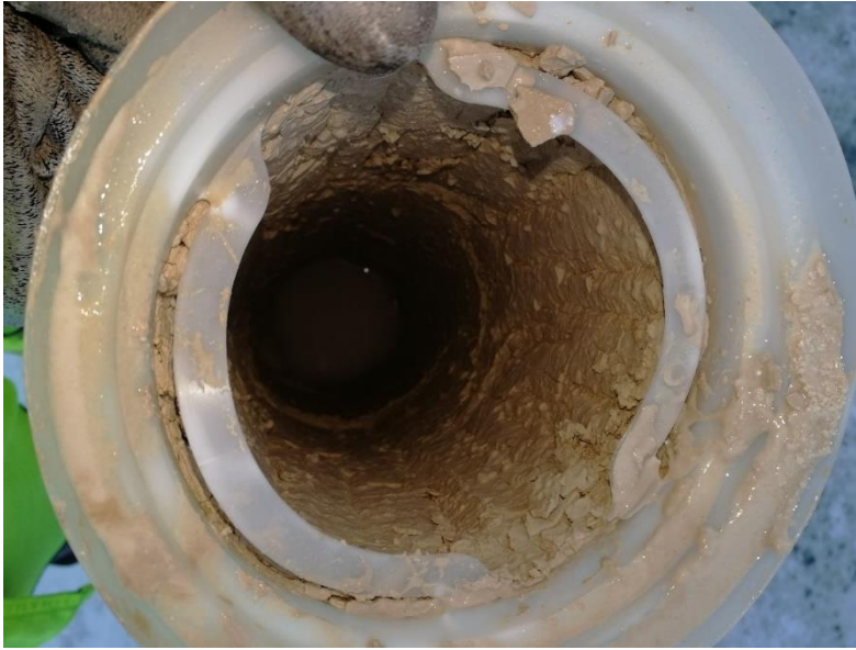
KUVA 18. UF-osion esisuodatin ensimmäisen ajojakson jälkeen
