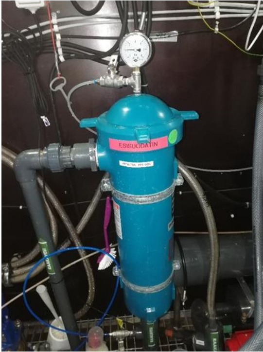
KUVA 14. UF:n esisuodattimena toimiva pussisuodatinyksikkö
