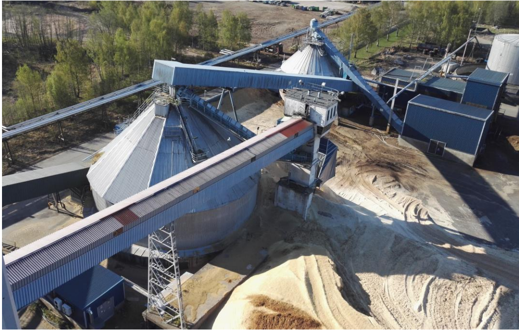
Kuva 1. Polttoaineenvastaanottoon liittyvät rakennukset (Koskenoja 2018)
