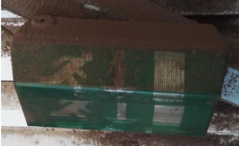
Kuva 9. Esimerkkikuva kuljetinsillalta löytyneestä opastevalaisimesta
