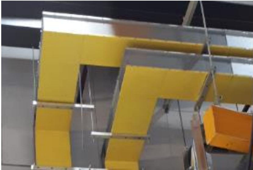
Kuvio 5. Kaapelointien suojaus koteloimalla.
