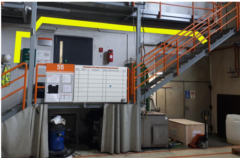
Kuvio 6. Kaapelireitti muuntajatilaan.
