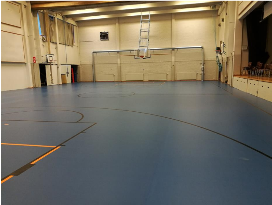
Kuva 9. Liikuntasalin lattian väliaikainen korjaus pistejoustavalla urheilulattialla sekä ulkoseinäpäättyyn asennettu poistoilmakanavisto.
