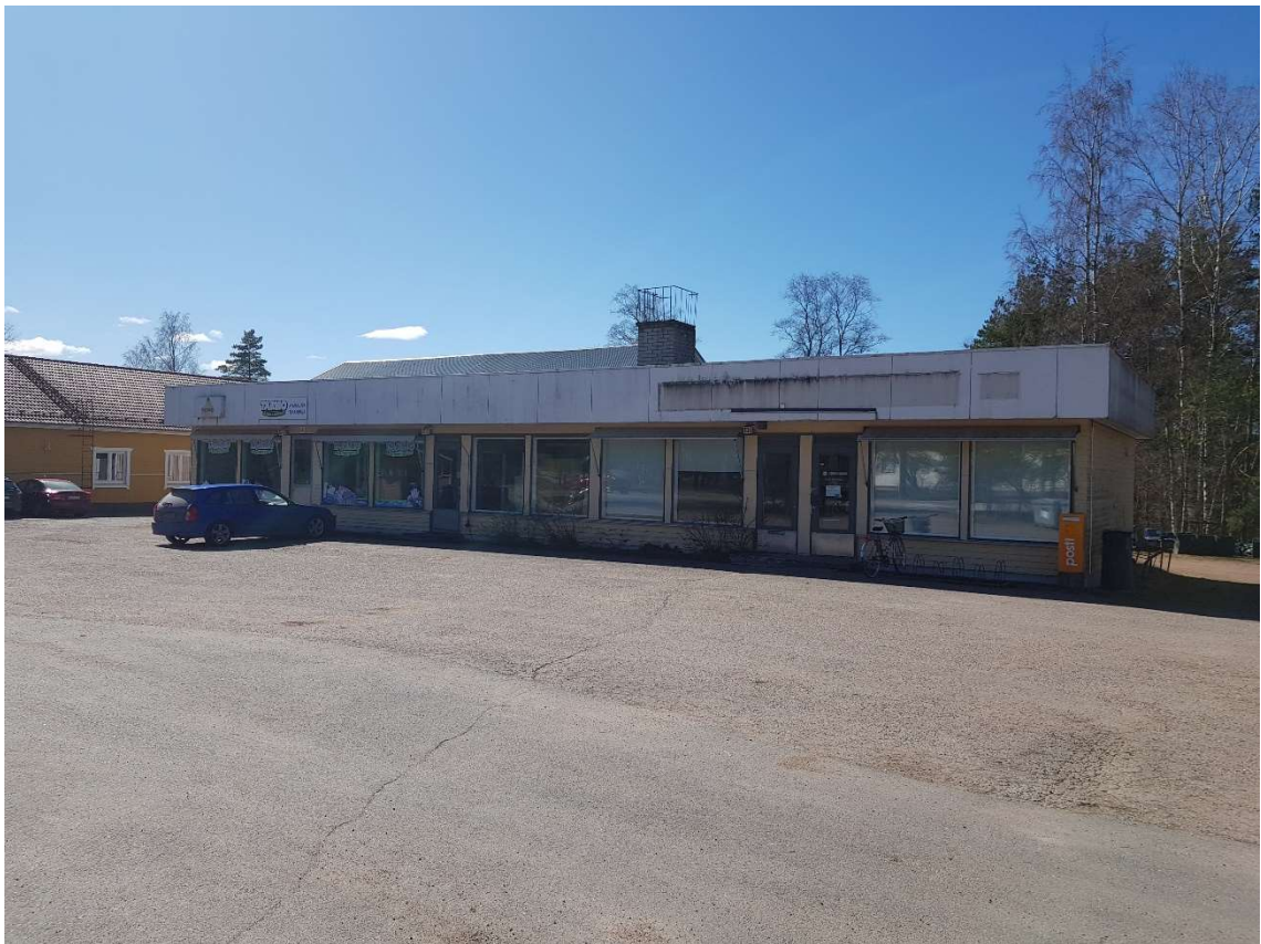
Kuva 3. Purettava liikerakennus, jonka paikalle uudisrakennus sijoittuu.
