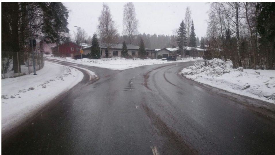
Kuva 44. Näkymä liittymäalueelle Ilveskadulta pohjoisen suunnasta.
