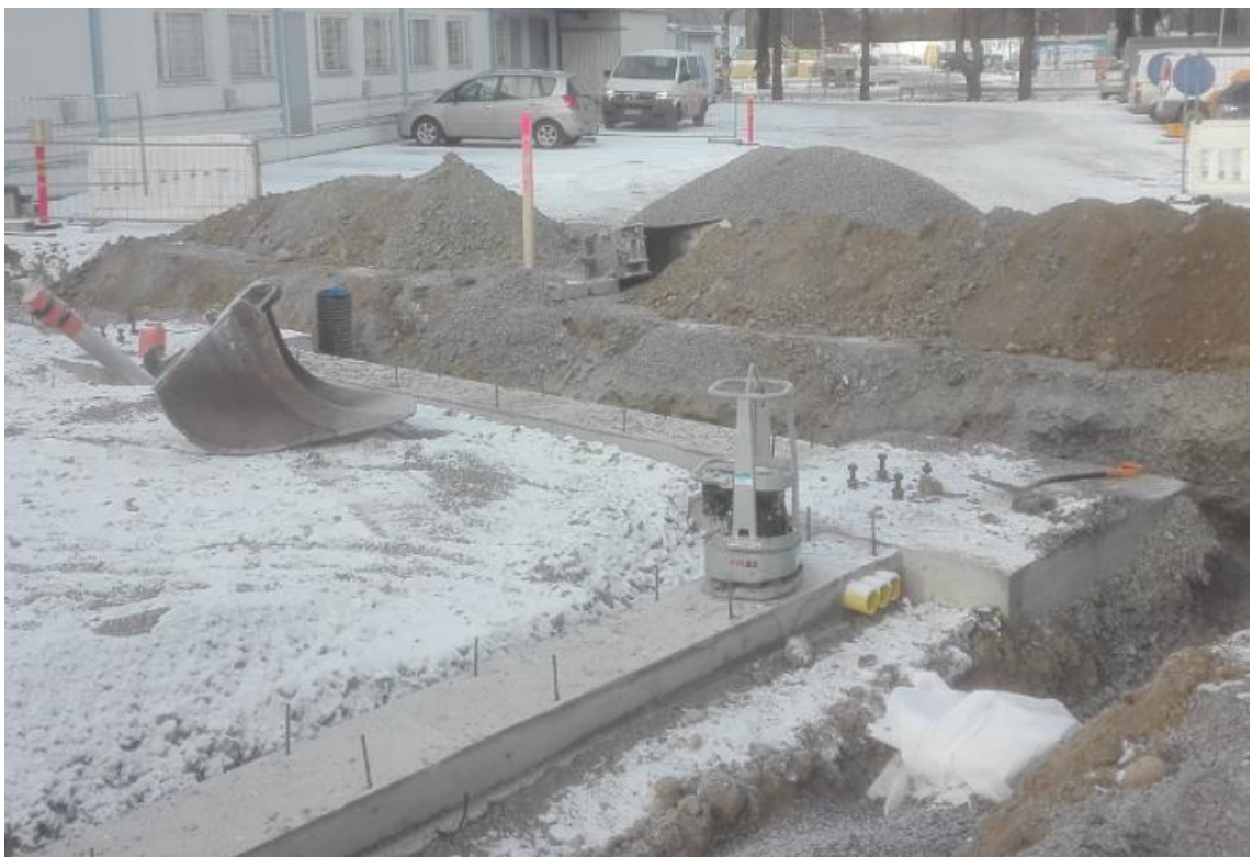
Kuva 4 Salaojaputkien asennus. M.Purolainen 2017
