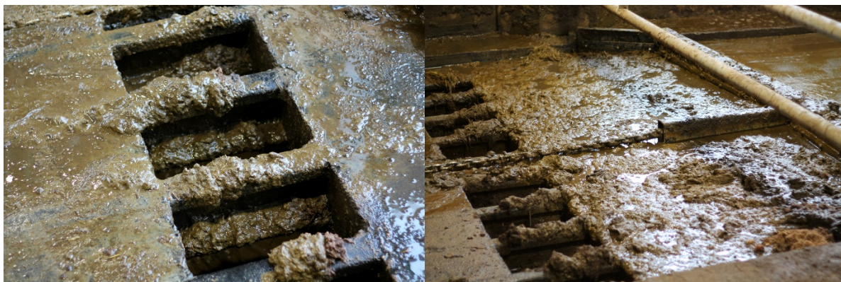
KUVA 23. Päätykuiluun on tehty junanraiteista pyöristetyt vahvikkeet, jotta traktorilla voidaan ajaa sen yli. Eläimet eivät satuta itseään niihin, jos jostain syystä päätyvät kuiluun (Tavaststjerna 2018-02-15.)
