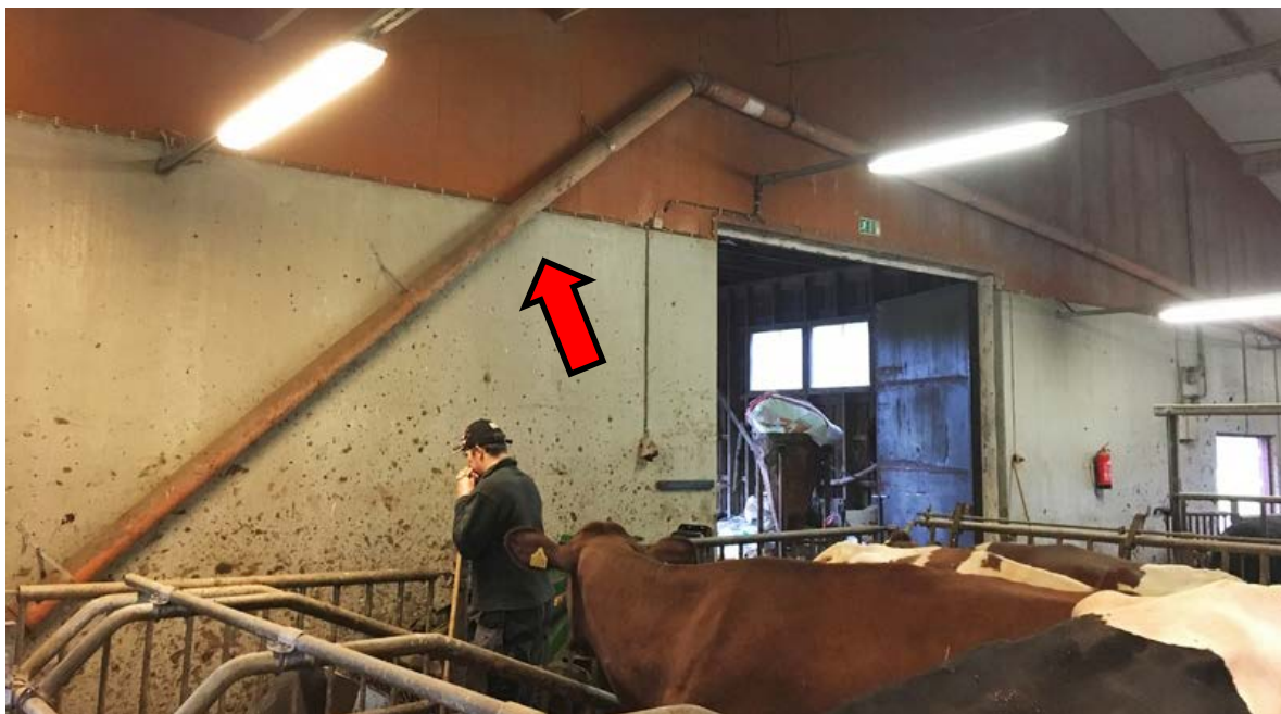
KUVA 11. Hiekkalanta kiertää kaivosta lähtevän halkaisijaltaan 160 millimetrin viemäriputken (nuoli) kautta takaisin kuiluun, minkä jälkeen hiekkalanta pumpataan kaivon kautta lietesäiliöön (Kuikka 2017-10-04).
