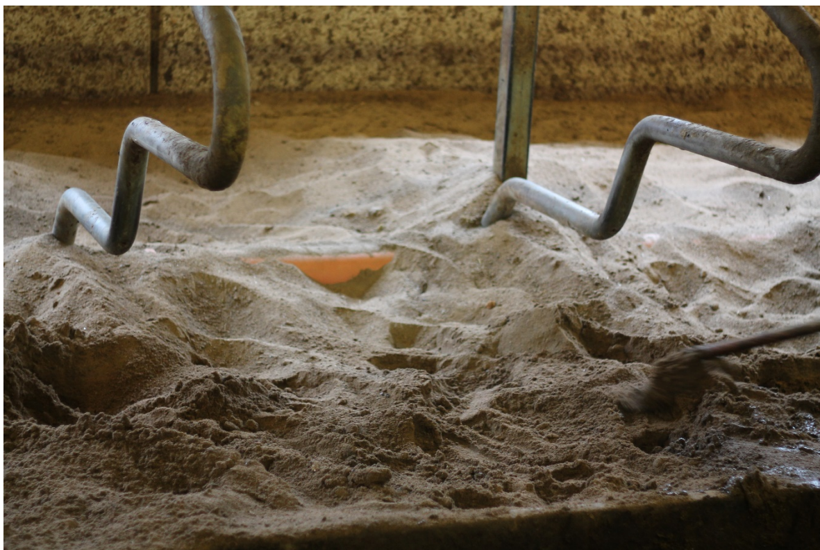
KUVA 6. Etuesteinä parsissa on halkaisijaltaan 160 millimetrin viemäriputki, mikä mahdollistaa lehmän astumisen askeleen verran sen yli, kun lehmä nousee parresta (Tavaststjerna 2017-10-04).
