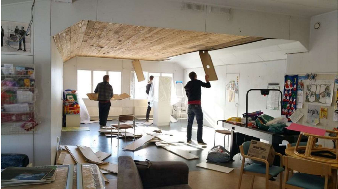
Kuva 1. Purkutöitä kerhotilassa. Huonekalut odottivat arviota käyttökelpoisuudestaan.
