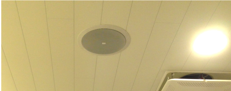
Kuva 2. Kosteutta kestävä puoliuppokaiutin asennettuna WC-tilan kattoon. Tjukanov Tommi 2016.
