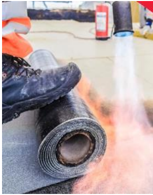
Kuva 5. Kuvassa oikea pintakermin hitsaustapa. Vaadittava purse näkyy kuvan alareunassa. (Kuva Varsinaisbitumi Oy:n esitteestä)
