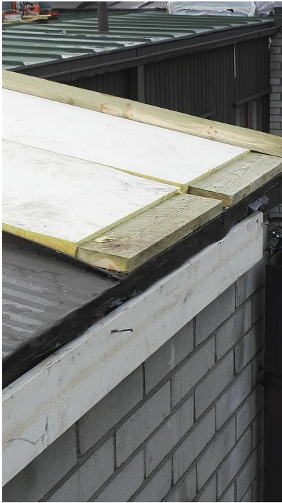
Kuva 3. Kuvassa näkyy päätyräystäslinja korotus, uusi otsalauta sekä konesaumapeltikaton saumojen väliin asennettava 50x200 kestopuu.
