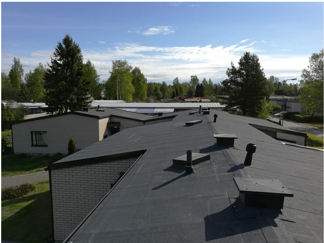
Kuva 6. Valmis uusi vesikatto.
