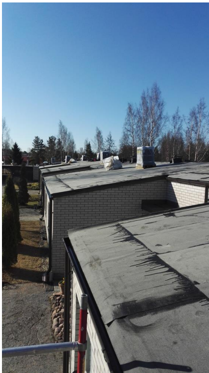
Kuva 4. As. Oy Huovinrivin vesikatto, kun pohjahuovat ovat oikein asennettuna.
