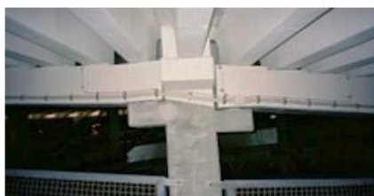
Bild: Betong tvärbalken
