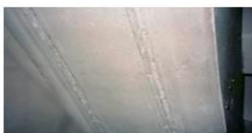
Bild. sågade spåren
