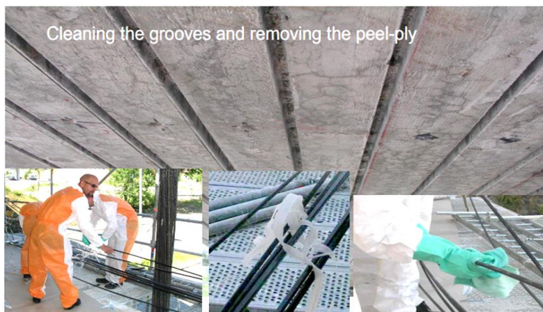
Bild 6, Förstärkningsarbete (Sto)
