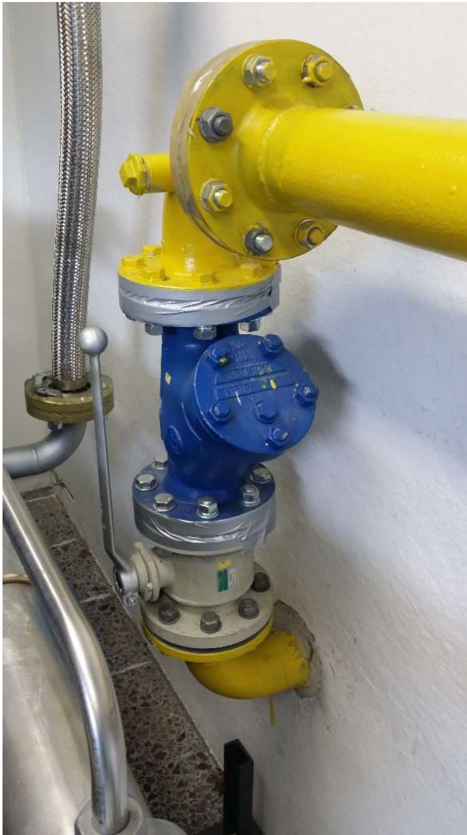
Kuva 10 Takaiskuventtiili johon höyrystin kiinnitetään kääntämisen jälkeen
