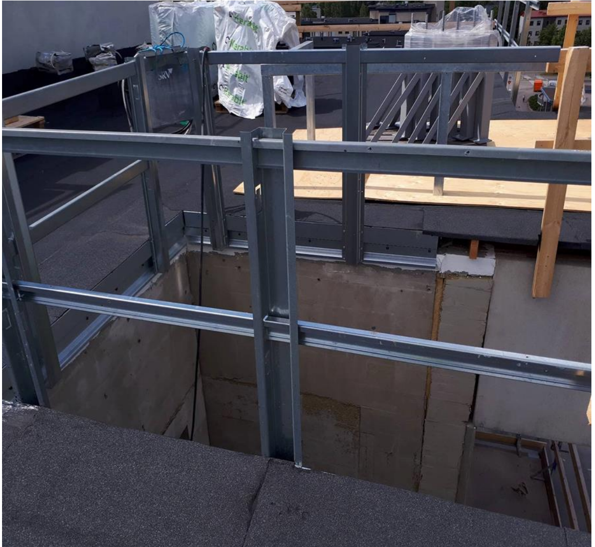
Kuva 19. Neilikkatie 8 työmaa. Turvakaiteet tulee samalla asennuksella kuin räystäs ja lisää työturvallisuutta. Turvakaiteet vuokrataan Ripatti Oy:ltä. Ripatti poistaa kaiteet, kun vesikatto on valmis.
