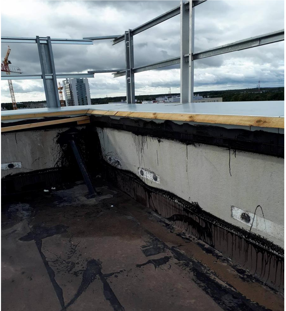
Kuva 17. Neilikkatie 8 työmaa. Vesikatto C-osa
