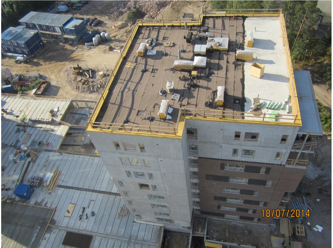
Kuva 23. Nihtitorpankuja 3 työmaa. Leca-soran päälle asennetaan betonilaatta, jonka päälle asennetaan pohja-/pintahuopa.
