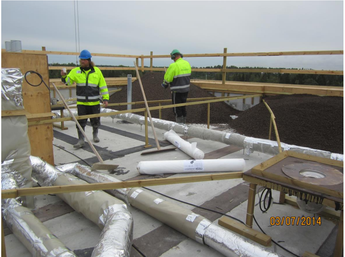
Kuva 22. Nihtitorpankuja 3 työmaa. Leca-asennus käynnissä
