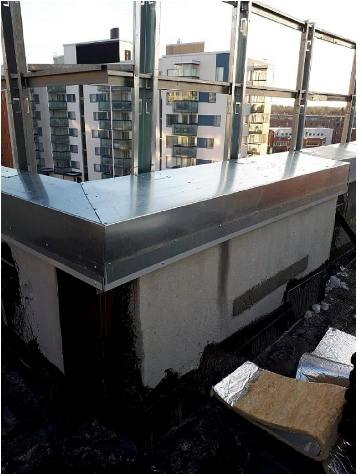
Kuva 15. Starlet-työmaa. Riprap-elementillä voi tehdä myös kulmakohdat helposti.
