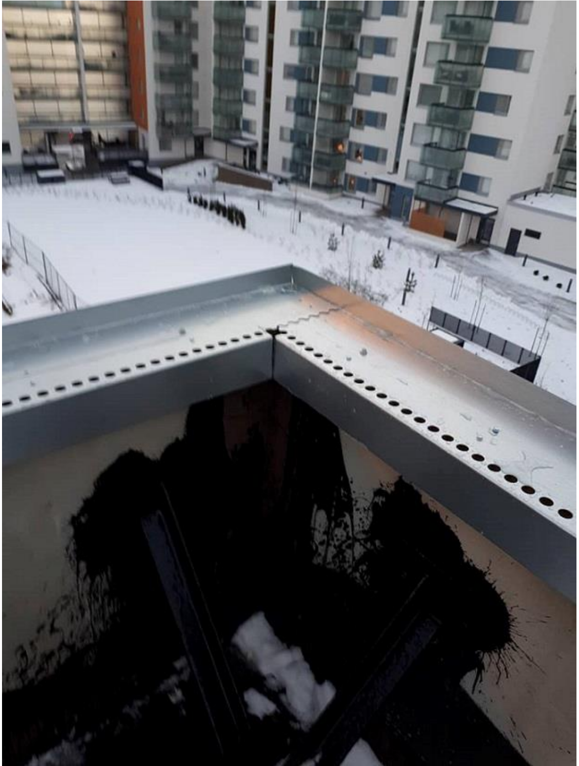
Kuva 13. Starlet työmaa. Aluslevy on helppo asentaa myös nurkkakohtiin.
