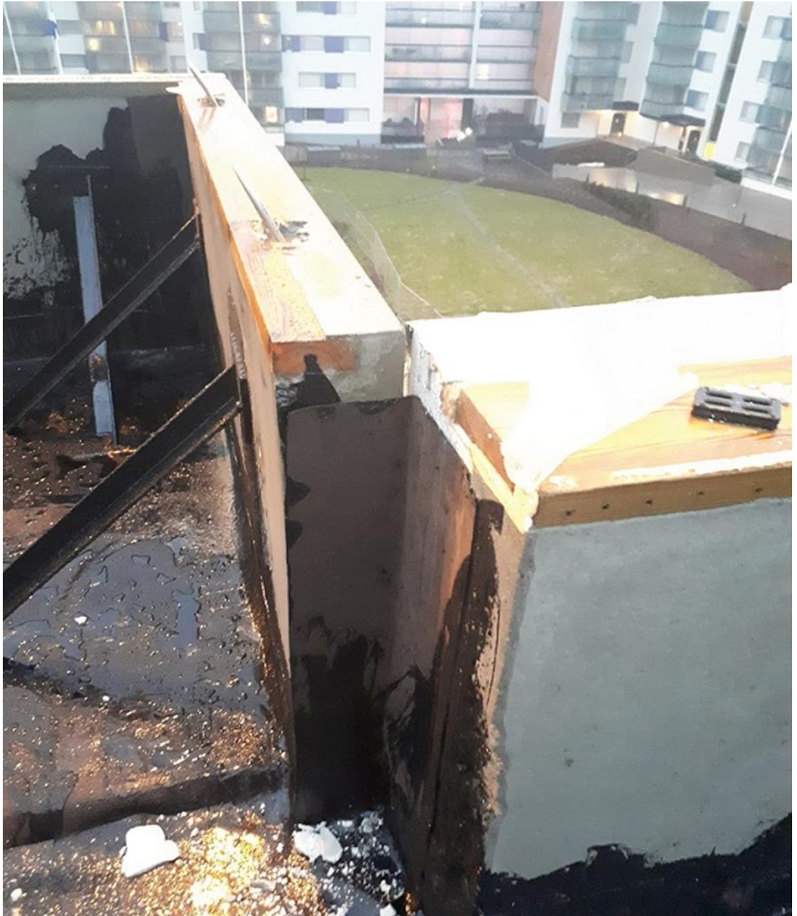
Kuva 10. Starlet työmaa vesikatto. Räystäiden asennus alkaa, kun KE-kivet on saatu asennettua ja tuettua. Tuet päällystetään bitumilla leca-soran takia korroosion estämiseksi.
