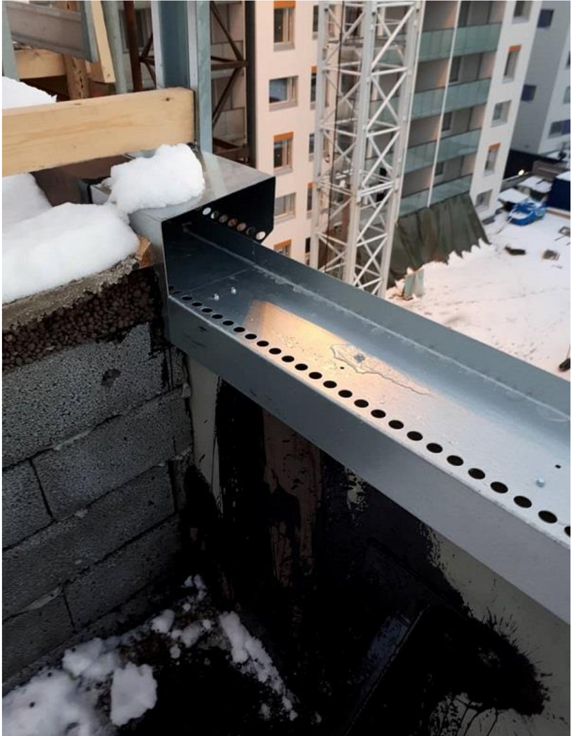
Kuva 12. Starlet työmaa. A- ja B-osan liitoskohta, johon on asennettu räystään aluslevy. Kuvassa näkyy myös hyvin tuuletusrako ulos ja sisäänpäin.
