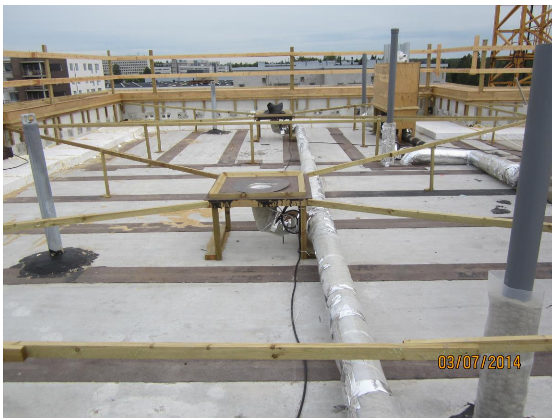
Kuva 20. Nihtitorpankuja 3 työmaa. Vesikatto ennen leca-soran asennusta. Räystäiden esivalmistelut tehty.
