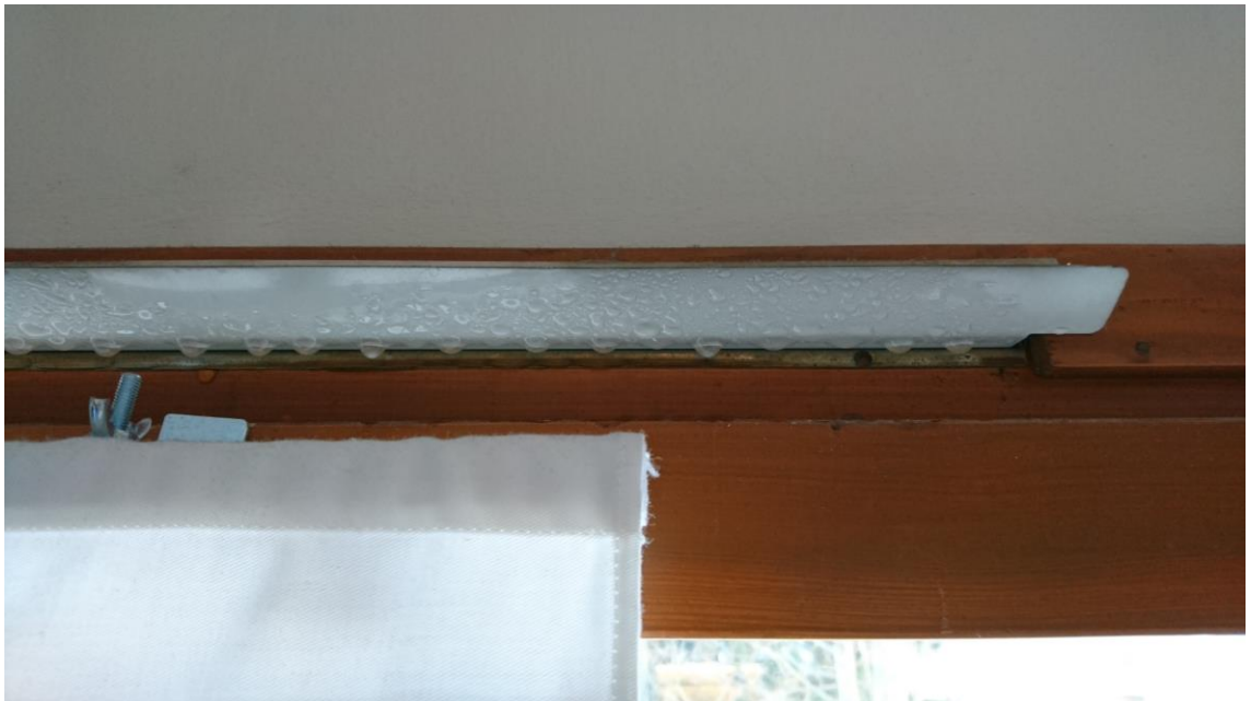
Kuva 34. Korvausilmaventtiili kondensoi ikkunankarmin päälle. Kuva asunnosta 1.
