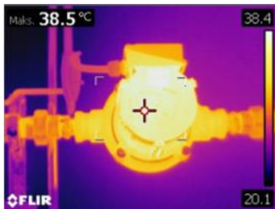
Kuva 30. Pumpun moottori normaalilämpötilassa [4].
