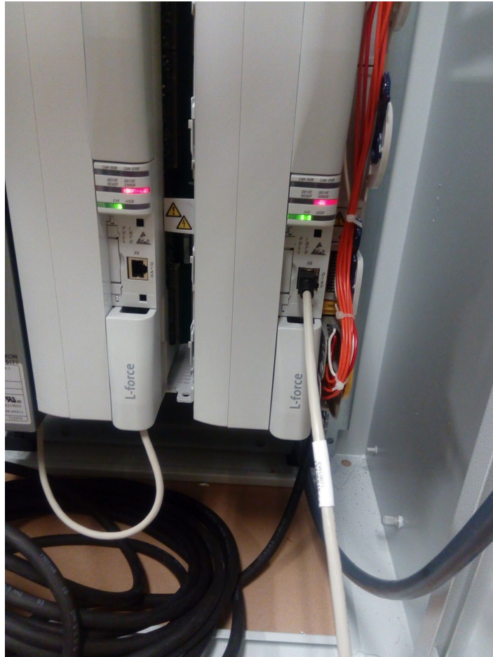
Figur 5. Regenerativ matningsmodul t.v. och drivenhet med programmeringskabel t.h.
