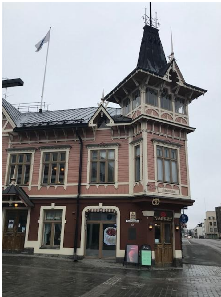
KUVA 1. Wilhelmiinan konditorian julkisivu Jyväskylässä. (Raati 2018)
