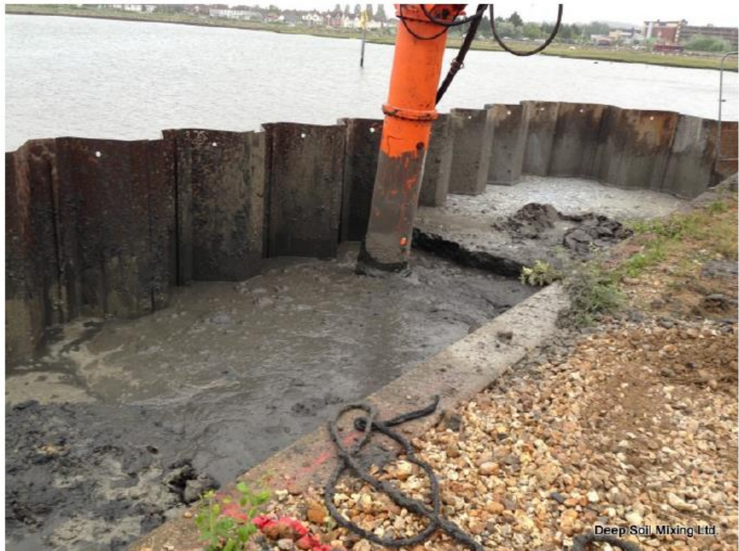
Kuva 31. Massastabilointityökone sekoittamassa solua 2. Taustalla on edellisenä päivänä sekoitettu solu 1, joka on jo alkanut kovettua. (Deep Soil Mixing Ltd 2013.)
