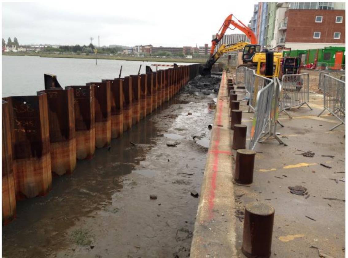
Kuva 30. Massastabilointikone ja avustava kaivinkone. Kaivinkone tarkistaa syvyyden hiekkaan saakka sekä poistaa mahdollisia sekoittamista haittaavia esteitä. (Deep Soil Mixing Ltd, 2013)
