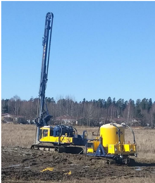
Kuva 2. Kuivaa sideainetta käyttävä pilaristabilointityökone ja sideaineen mobiilivälisäiliö eli "possu"
