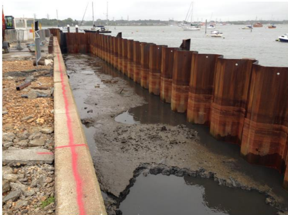
Kuva 28. Vanha laituri ja pehmeää merenpohjasilttiä. (Deep Soil Mixing Ltd, 2013)
