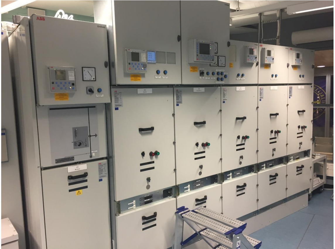
Kuva 7. 10 kV Keskijännitekojeisto
