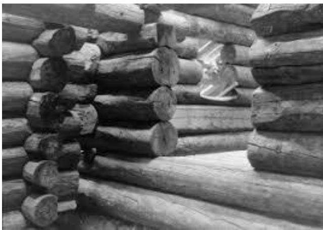
Kuva 1. Valokuva hirsirunkorakenteesta talon pystytysvaiheessa vuonna 1939. /30/
