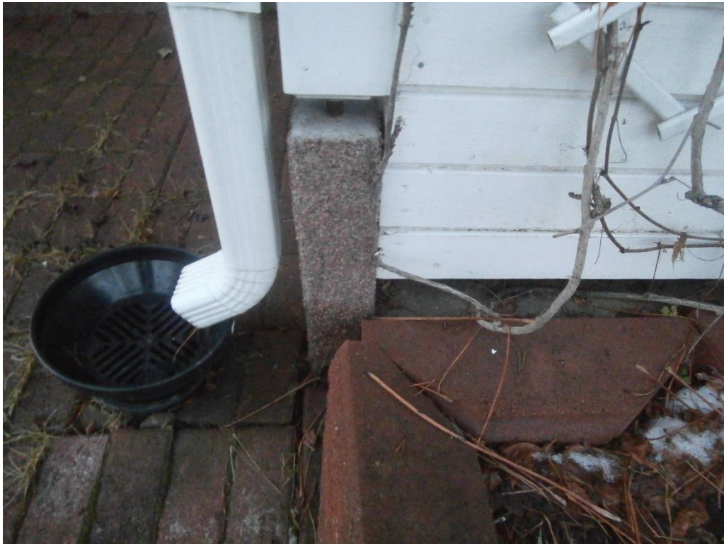
Kuva 2. Puhdistettu rännikaivo.
