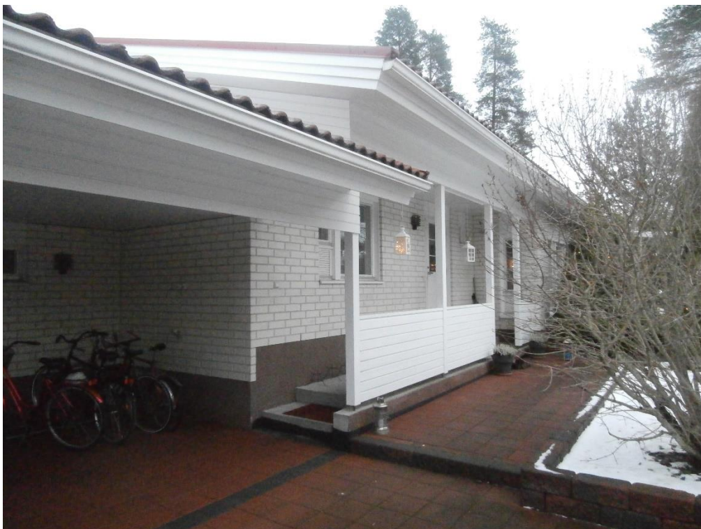
Kuva 1. Huoltomaalatut räystäslaudoitukset.
