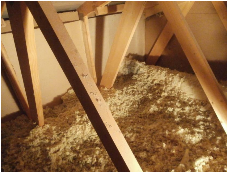
Kuva 10. Yläpohjan lämmöneristettä.
