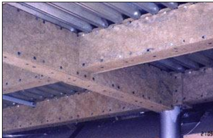
Kuva 8. Mineraalivillalevyllä suojattua rakennetta /26/.
