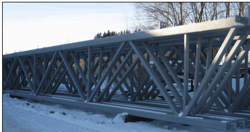
Kuva 10. Palosuojamaalattuja kattoristikoita /27/.
