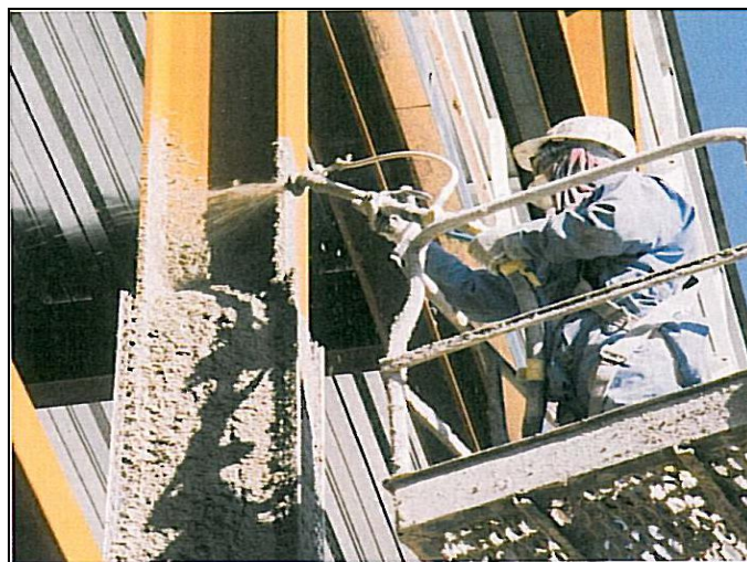
Kuva 9. Palosuojaruiskutteen asennusta /25/.
