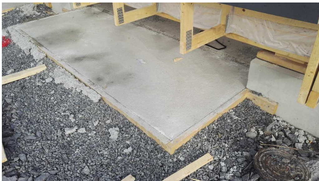
KUVA 8. Valmis paikallavalettu ajoluiska
