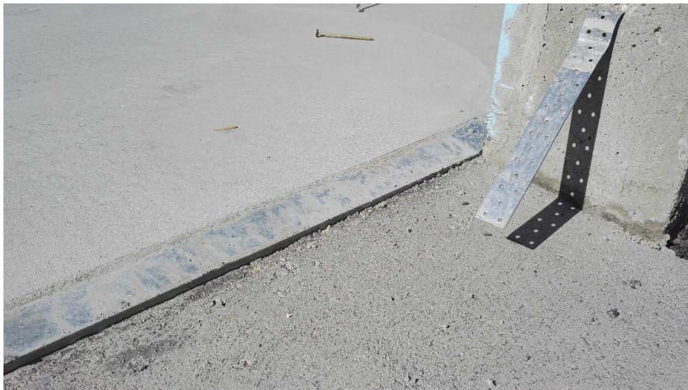
KUVA 12. Sinkitty kulmarauta asennettuna
