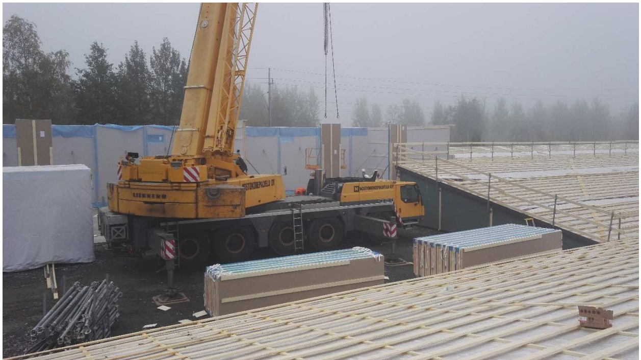
KUVA 2. Elementtien pystytys
