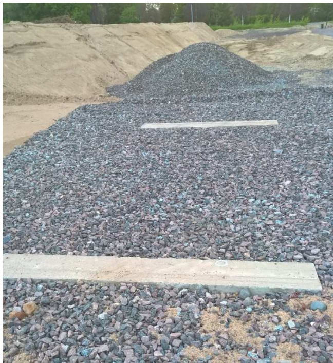
KUVA 6. Teknisen tilan elementin perustukset (20)
