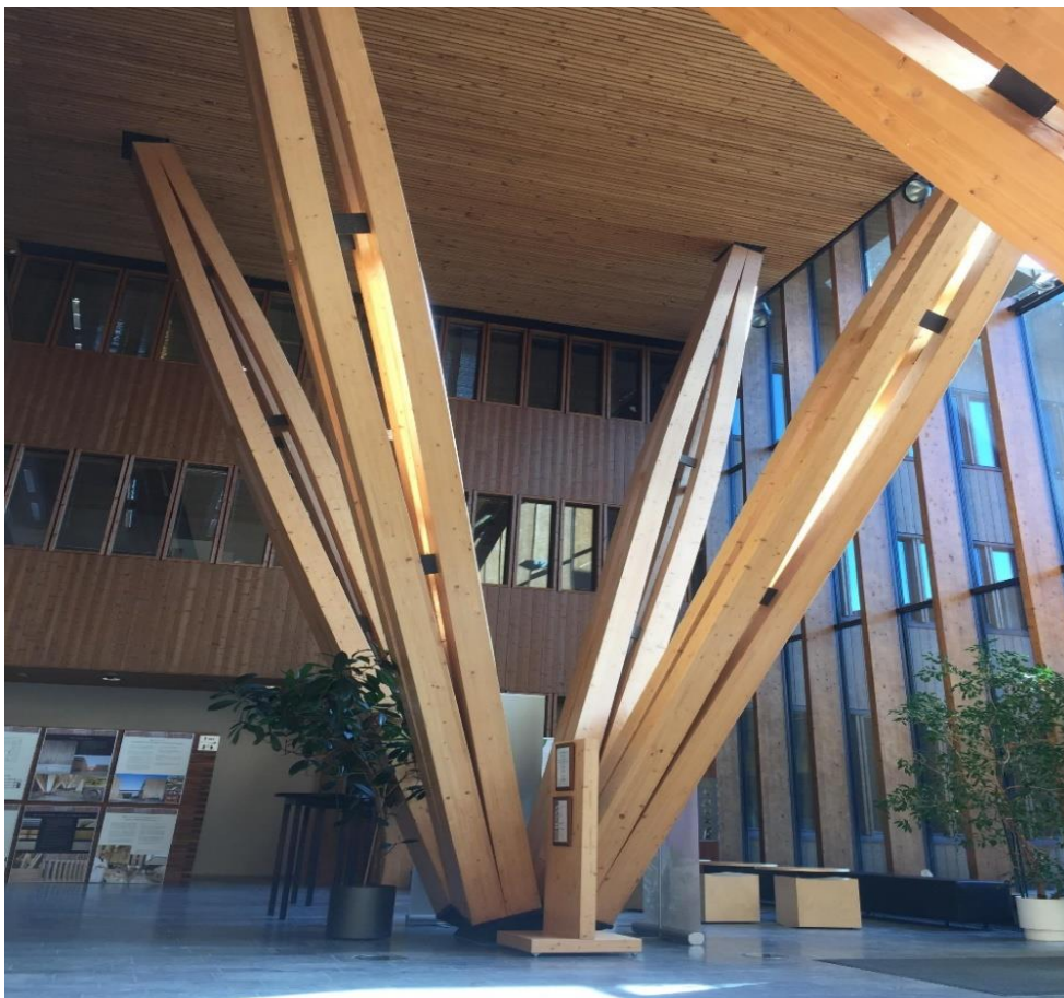
Kuva 63. Kimppupilari Metla-talossa. Tekijän kuva.
