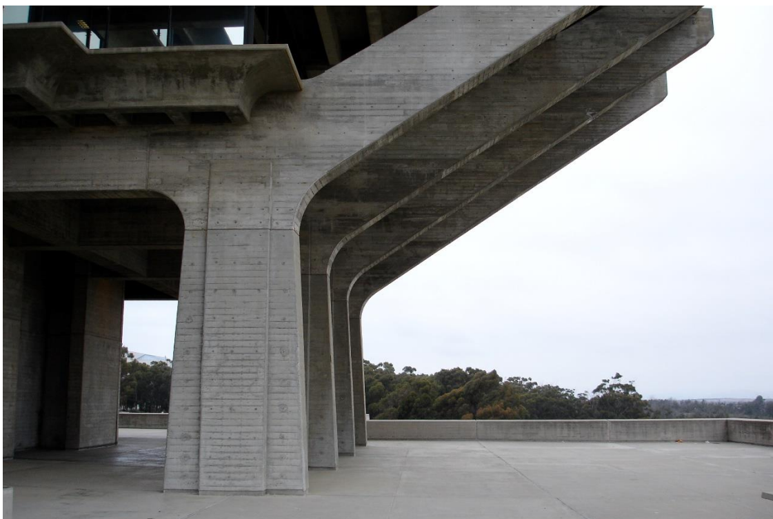
Kuva 45. Geisel-kirjaston betonijalustat. Kuvaaja Omar Bárcena. [77]
