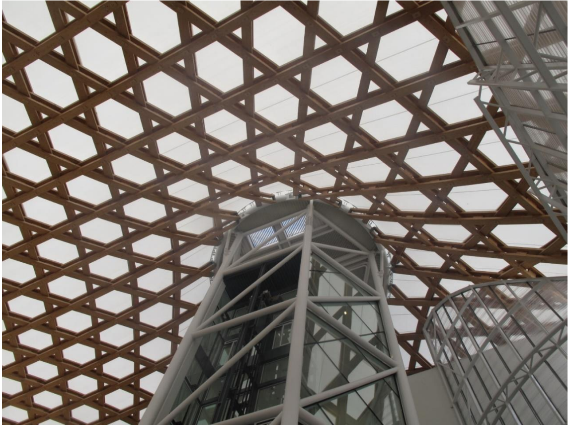
Kuva 51. Pompidou-Metzin kantavat teräs ja puu rakenteet. Kuvaaja Martin Gautron. [88]
