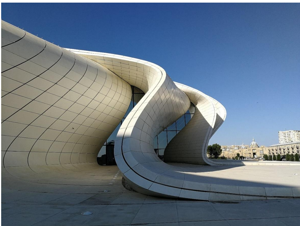
Kuva 22. Heydar Aliyevin levyillä pinnoitettu teräsrunko. Kuvaaja Aleksandr Zykov. [43]
