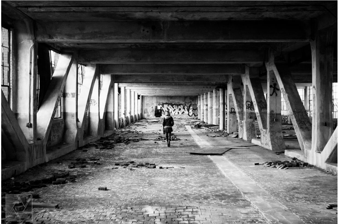
Kuva 38. Betonipilarit ja palkit rakennuksen kannattajana. Kuvaaja Kyle J. Schultz. [69]
