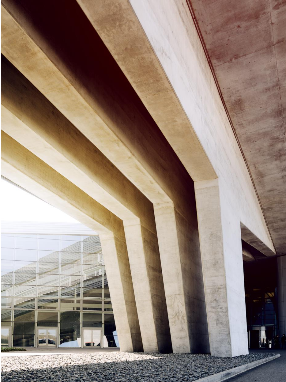
Kuva 43. BMW Central -rakennuksen betonirakenteet. Kuvaaja Felix Meyer. [74]
