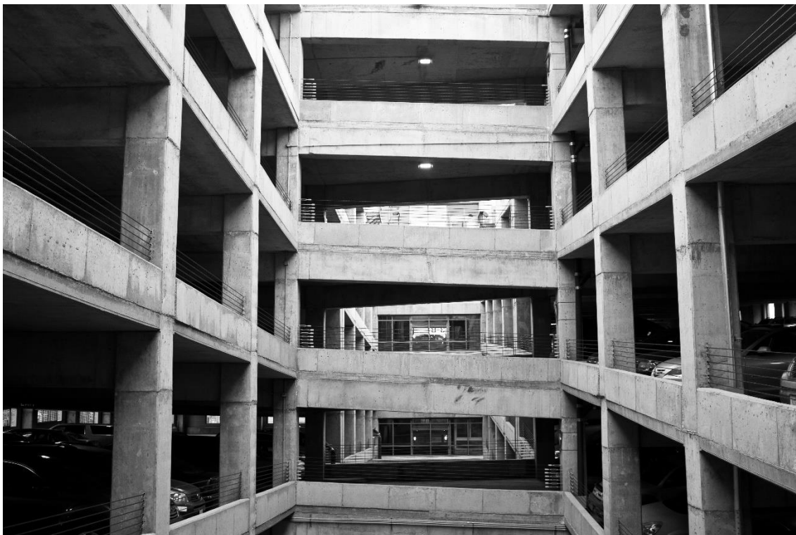
Kuva 39. Pysäköintihallin pilari-palkkijärjestelmä. Kuvaaja Phil Roeder. [70]
