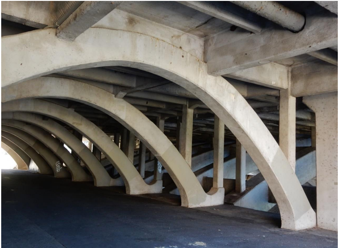
Kuva 41. Betonikaaripalkit. Kuvaaja Michael Coghlan. [72]
