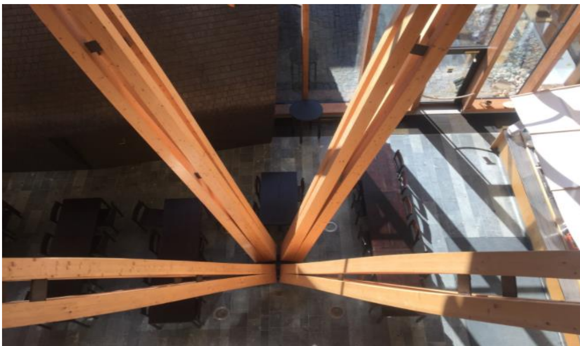
Kuva 64. Kimppupilari ylhäältä päin kuvattuna. Tekijän kuva.
