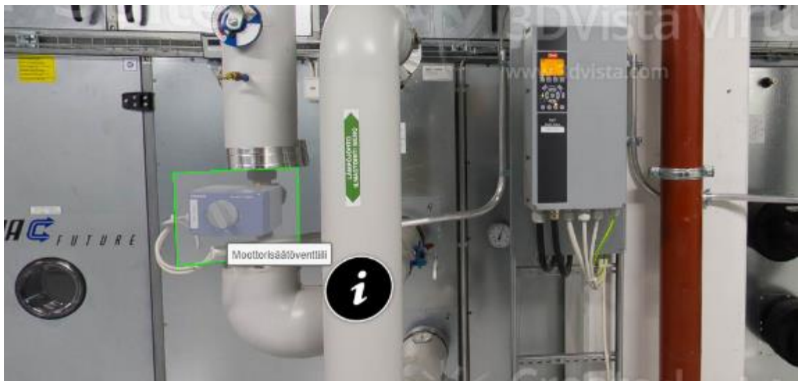
KUVA 5. Ilmastointipatterin säätöventtiili
