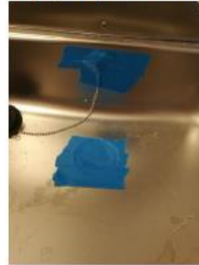
Teknisentilan lavuaari teipattu
