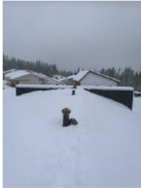
Katolla tulpattu kanavat
