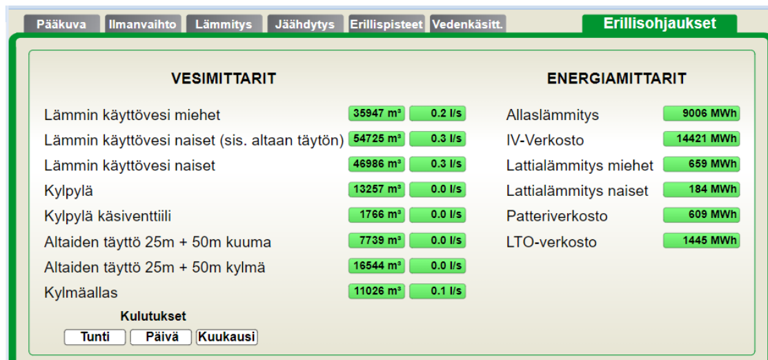
KUVA 9. Kohteen vesi- ja energiamittaukset, kiinteistöautomaatio
