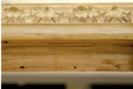
Kuva 5. Karkeata työstäjälkeä falssin seinämässä.
