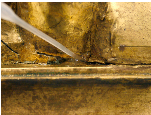
Kuva 42. Injektoin kalaliimaa muovipipetillä halkeamiin.
