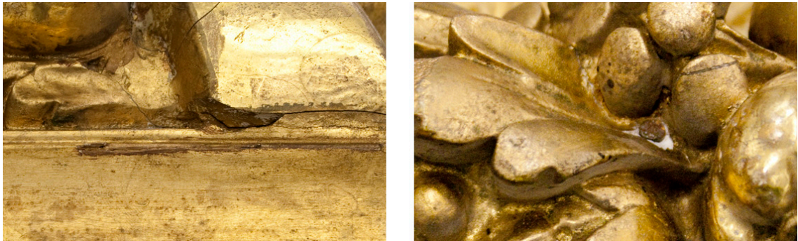
Kuva 36. Plastista täydentämistä kaipaavia vauriokohtia.
