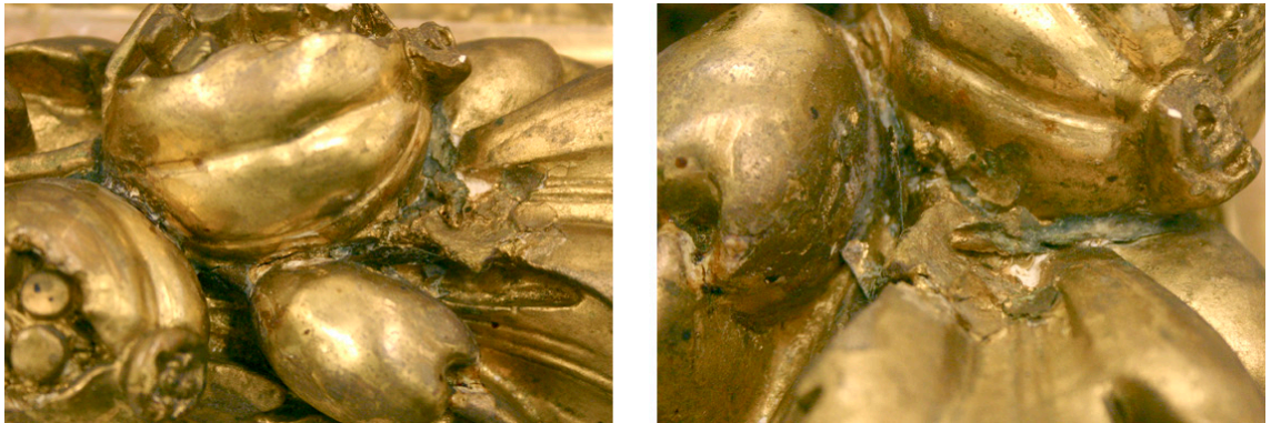
Kuva 32. Liimausaineiden aiheuttamia vaurioita hedelmämuotojen työssä.
